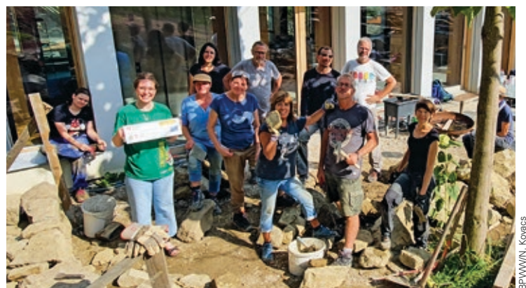
Trockensteinmauer-Kurs in Wien-Döbling
