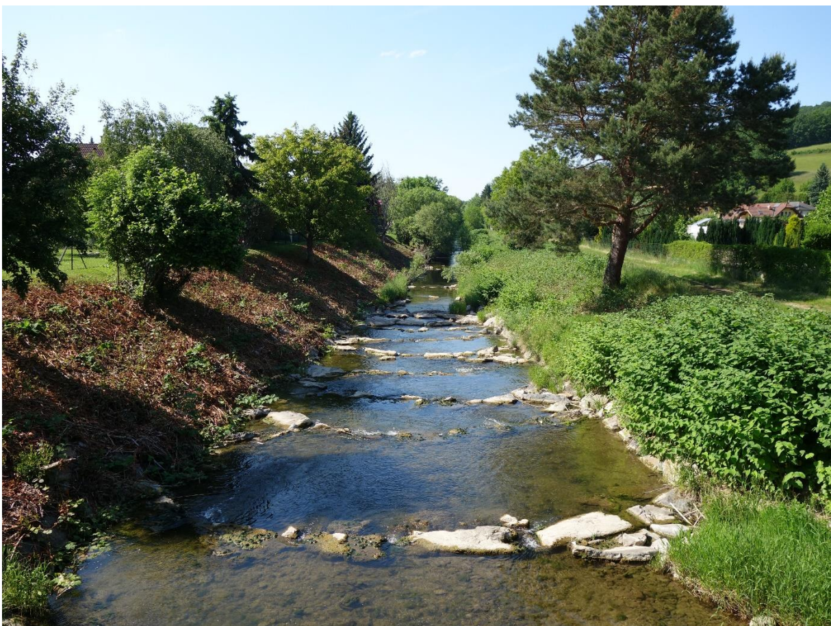
Abbildung 27: Stark verbauter Abschnitt des Laabenbaches in Leitsberg (Foto: BPWW/J. Scheibelhofer)
