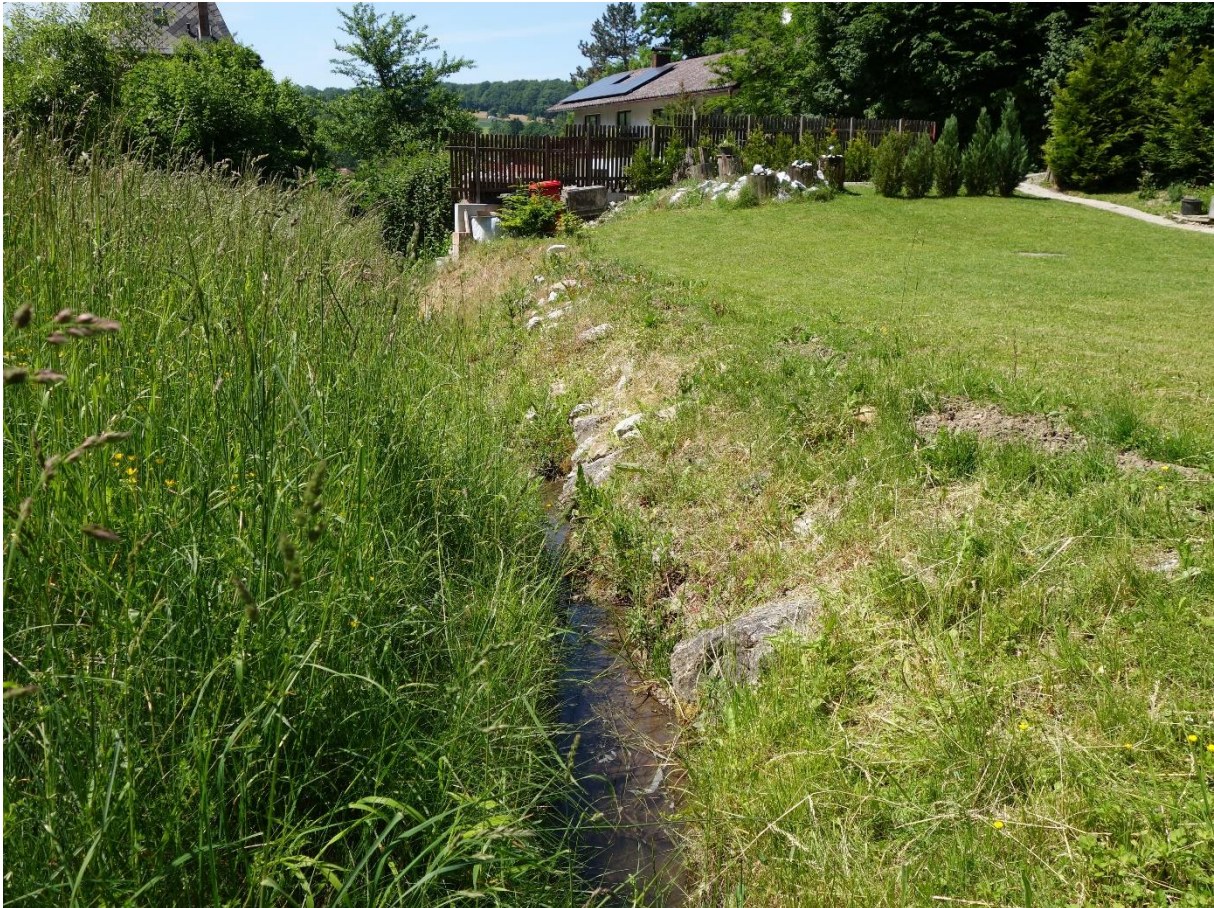
Abbildung 114: Naturferner Verlauf des Hocheichberggrabens im Siedlungsgebiet (Foto: BPWW/J. Scheibelhofer)
