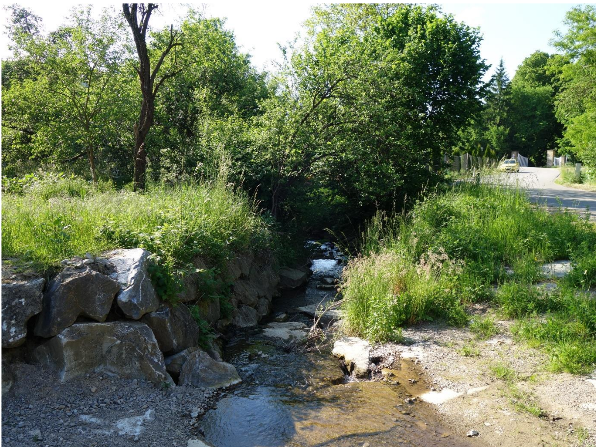
Abbildung 111: Uferbefestigungen am Großgrabenbach in Innermanzing (Foto: BPWW/J. Scheibhofer)
