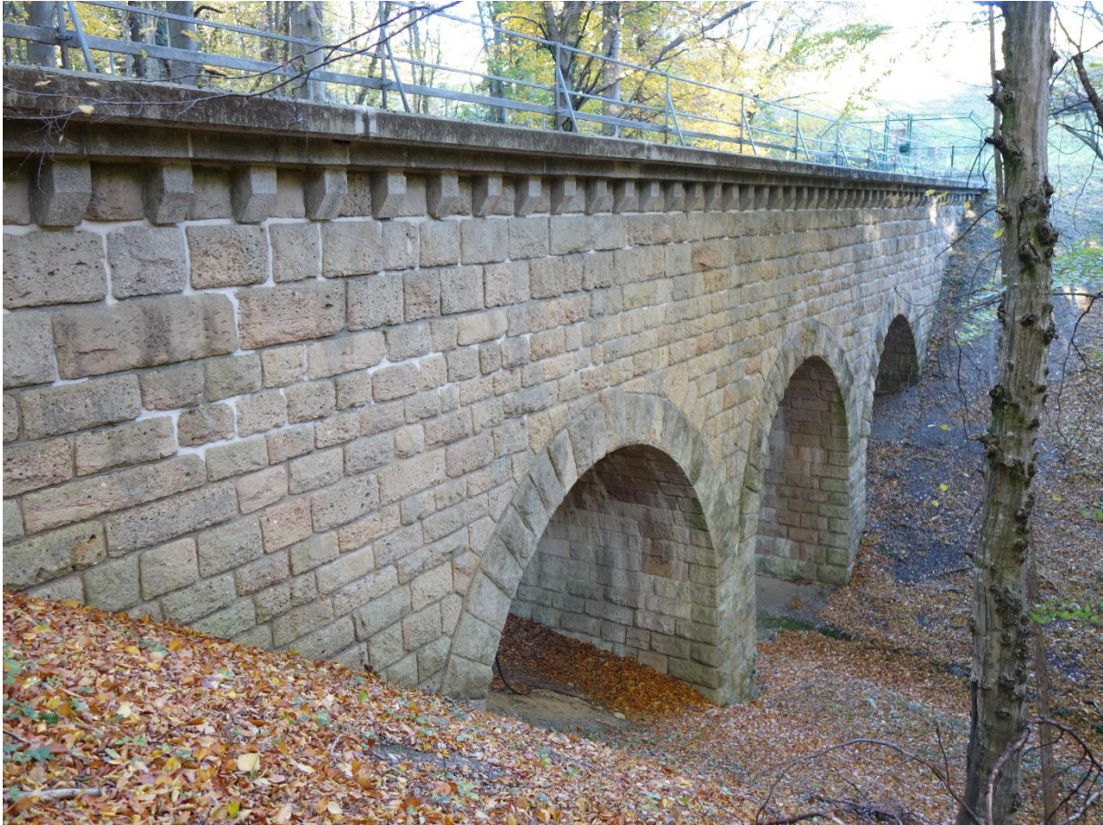
Abbildung 105: Die Hochquell-Wasserleitung quert den Böhmerhofgraben beim Ödgraben-Aquädukt (Foto: BPWW/J. Scheiblhofer)
