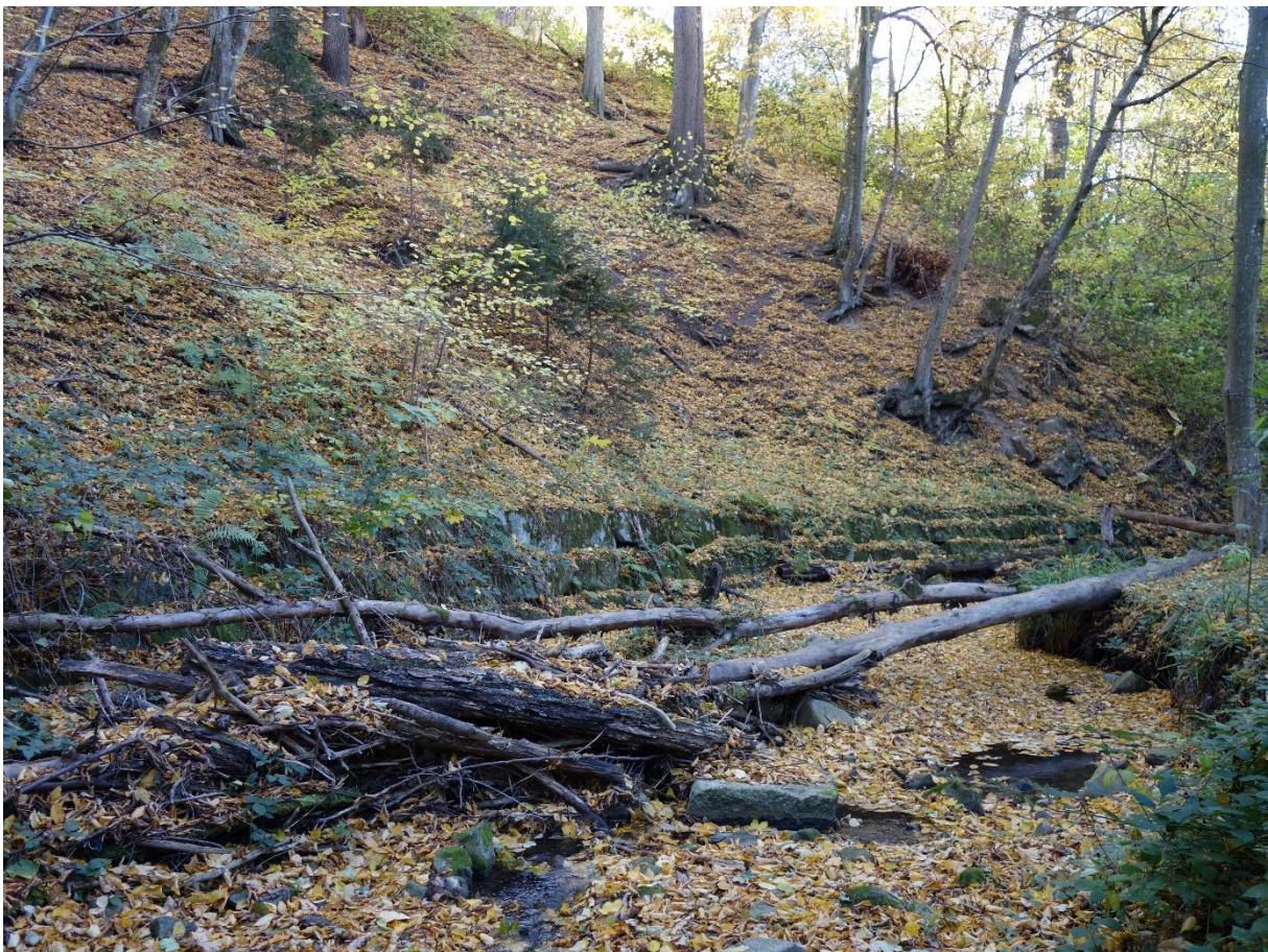
Abbildung 127: Verfallender Uferschutz am Ödengraben Nähe des Siedlungsgebietes an der Kienbergstraße (Foto: BPWW/J. Scheibhofer)
