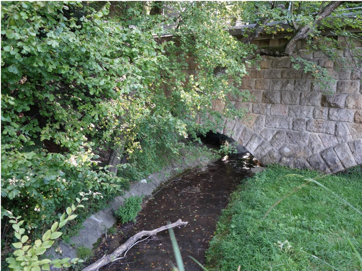
Abbildung 109: Sohlenbefestigung am Götzwiesenbach beim Aquädukt nach dem Hochwasser-Rückhaltebecken (Foto: BPWW/J. Scheibhofer)
