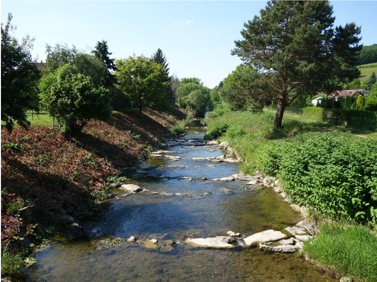
Abbildung 119: Stark verbauter Abschnitt des Laabenbaches in Leitsberg (Foto: BPWW/J. Scheiblhofer)
