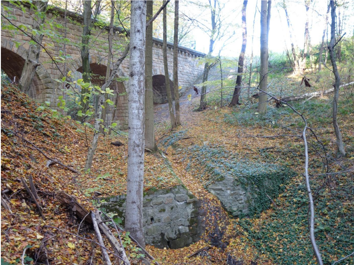
Abbildung 106: Hohe Grundschwelle nach dem Ödgraben-Aquädukt (Foto: BPWW/J. Scheiblhofer)
