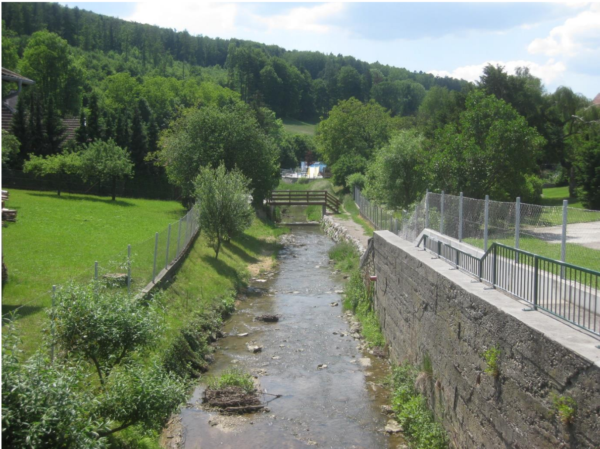
Abbildung 122: Stark regulierter Lengbach bei der Brücke der Hauptstraße nach der Einmündung des Harterbaches (Foto: BPWW/P. Biskup)
