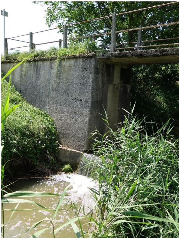
Abbildung 65: Betonierter Absturz bei einer gesperrten Brücke am Moosbach (Foto: BPWW/J. Scheibelhofer)
