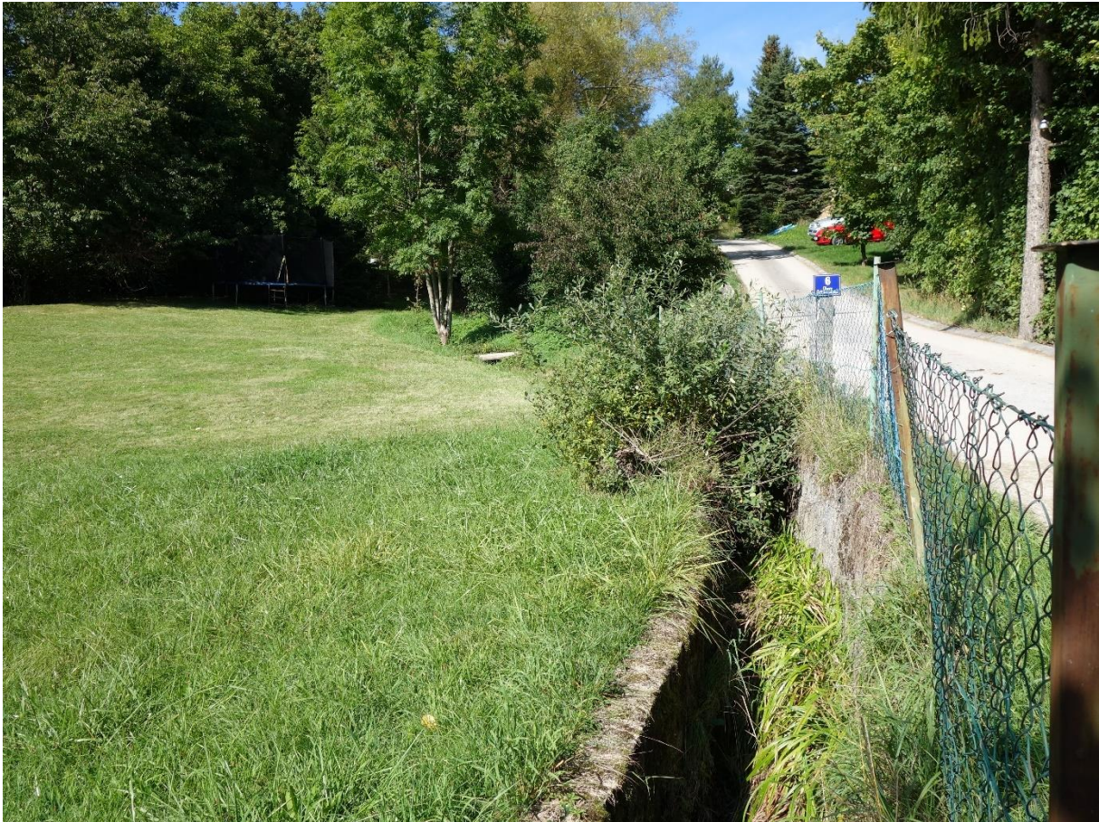
Abbildung 73: Ödlitzgraben kurz vor der Einmündung in den Buchbach (Foto: BPWW/J. Scheibhofer)
