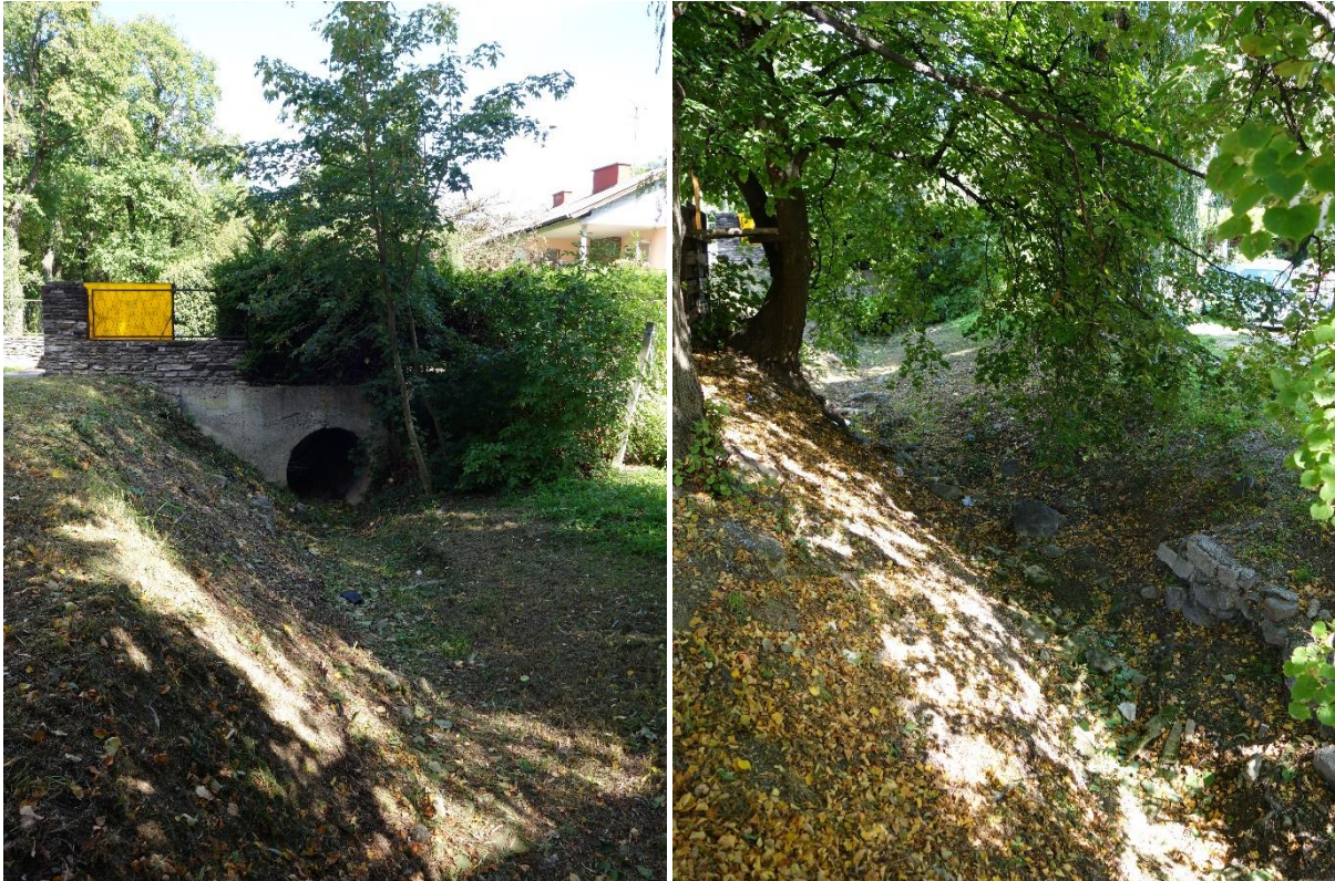
Abbildungen 76 und 77: Im Unterlauf entlang der Buchbachgasse ist der Bach stark verbaut und zum Teil unterirdisch verrohrt (Fotos: BPWW/J. Scheibelhofer)
