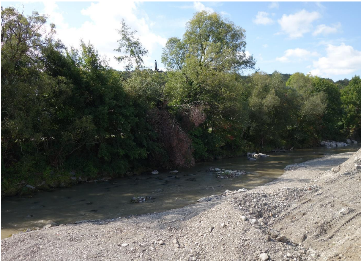
Abbildung 82: An der Josef Lechner Straße finden derzeit umfassende Bauarbeiten an der Triesting statt (Foto: BPWW/J. Scheiblhofer)
