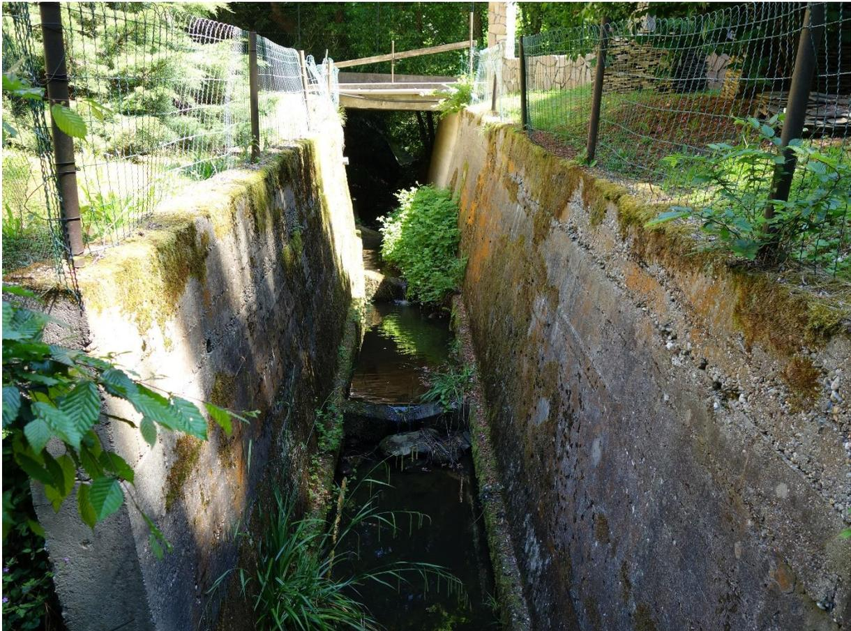
**Abbildung 61: Verbauter Abschnitt des Steinwinkelgrabens am Rand des Siedlungsgebietes nach der Einmündung des Finsterleitengrabens mit Grundswellen (Foto: BPWW/J. Scheibhofer)**
