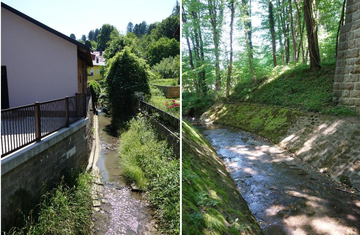
Abbildungen 52 und 53: Der Nagelbach ist in großen Abschnitten hart verbaut. Links: Nagelbach beim Freiheitsplatz. Rechts: Nagelbach beim Aquädukt über die Schattastraße (Fotos: BPWW/J.Scheibelhofer)
