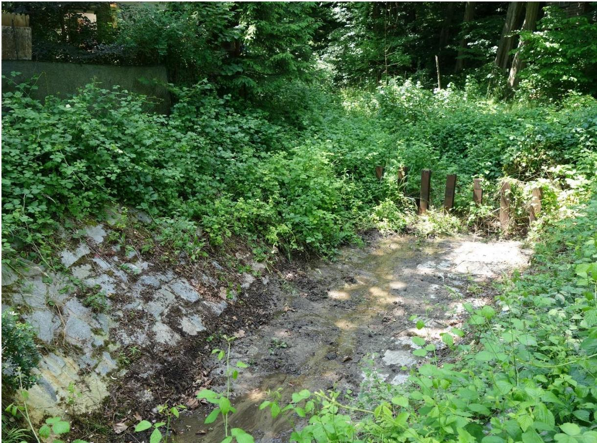
Abbildung 49: Verbaute Sohle und Wildholzrechen (hinten im Bild) am Bahnofsgraben vor der Querung der Westbahnstrecke (Foto: BPWW/J. Scheiblhofer)
