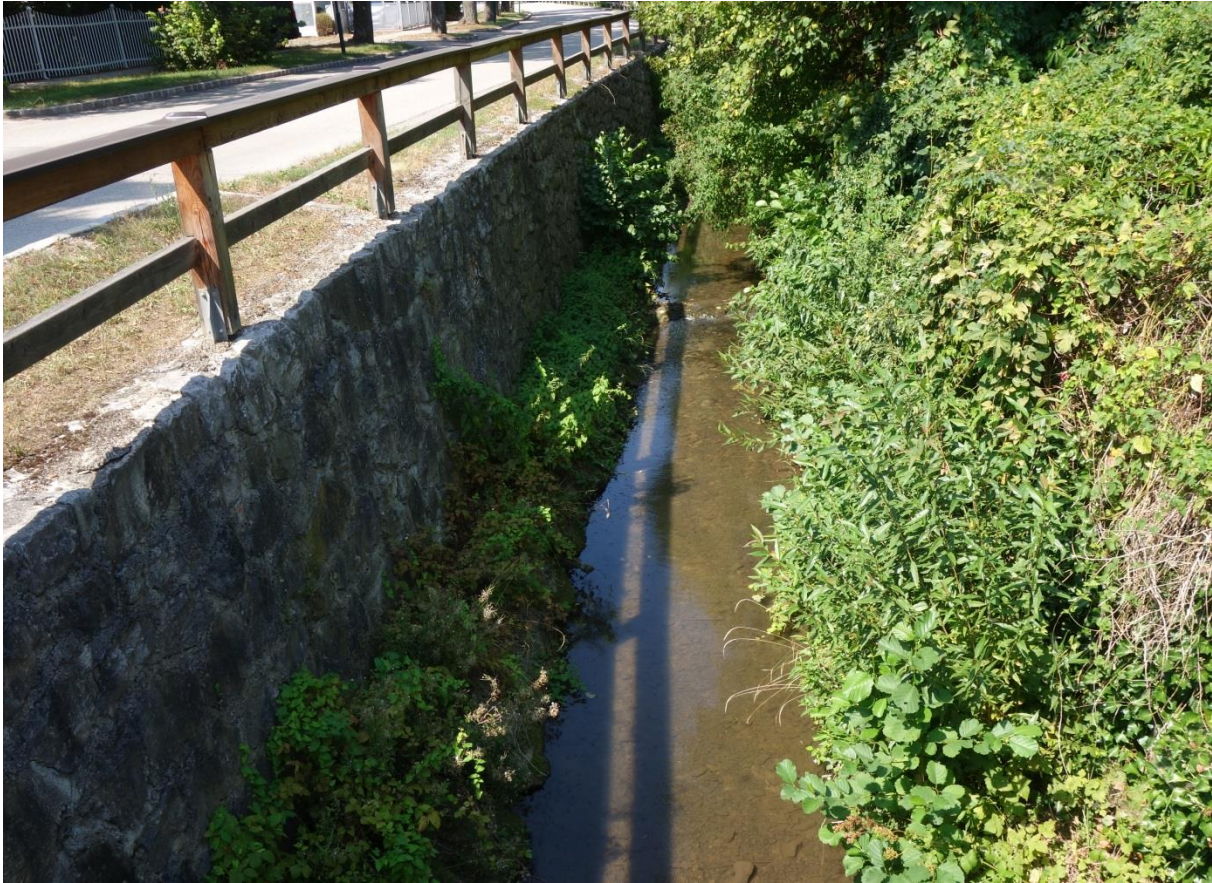
Abbildung 26: Mödlingbach mit Uferbefestigung bei der Brücke Wiesengasse (Foto: J. Scheibhofer)
