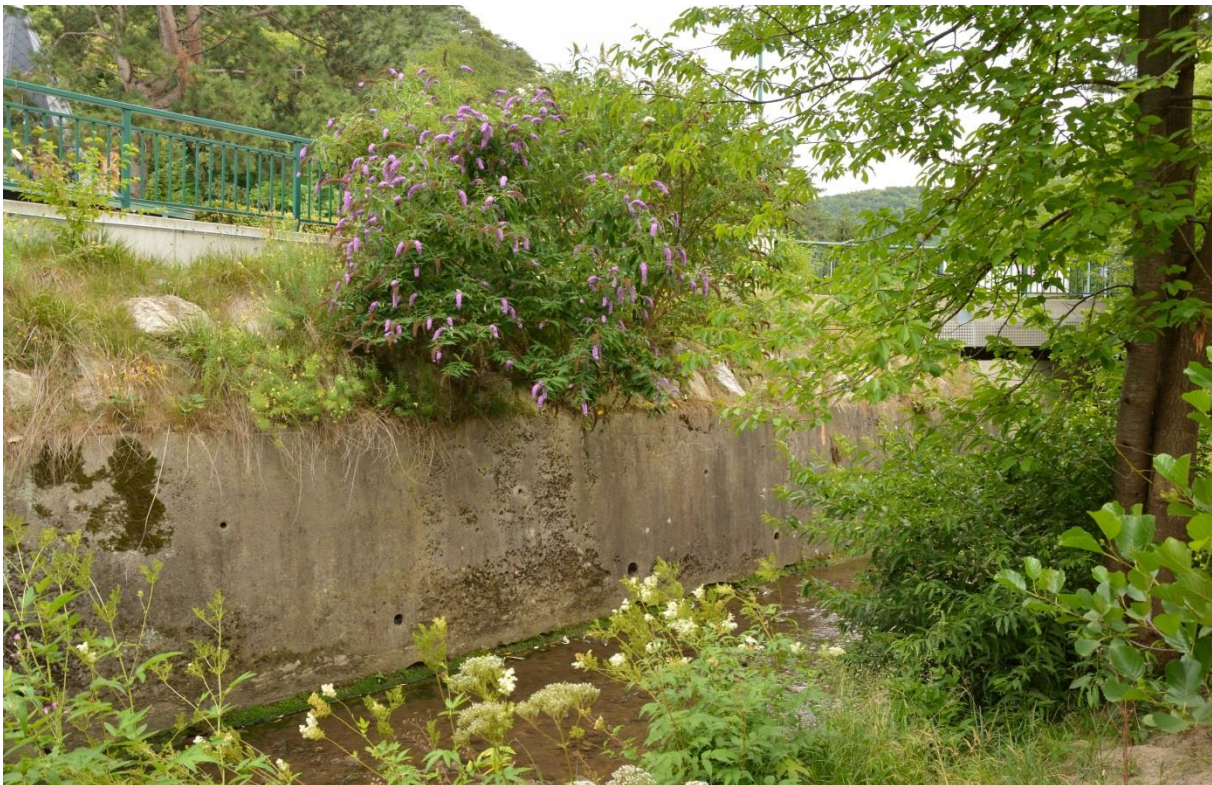
Abbildung 49: Mödlingbach mit Uferverbauung im Ortsgebiet (Foto: G. Weiss)
