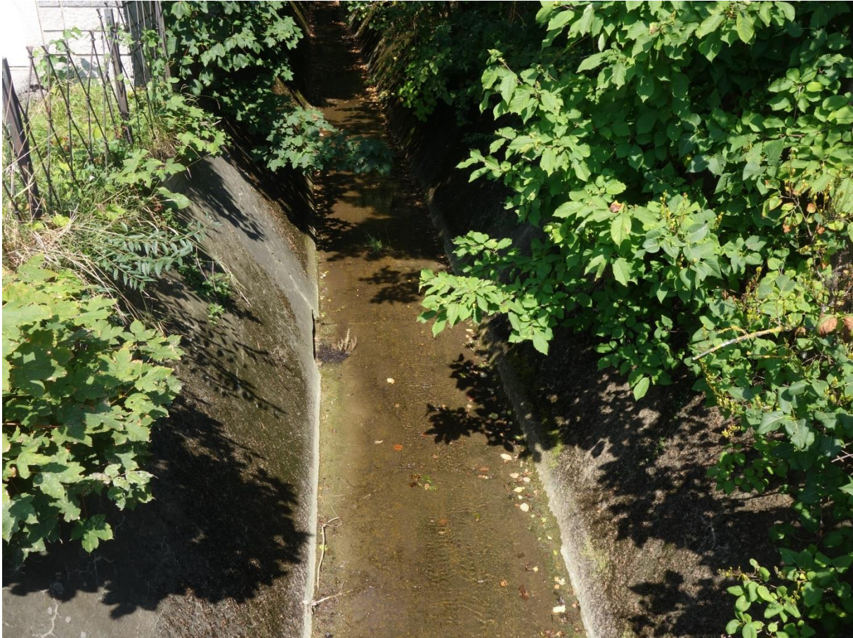
Abbildung 52: Hart verbauter, betonierter Abschnitt des Schneiderbachs nach Unterquerung Siegenfelder Straße vor der Einmündung in den Mödlingbach (Foto: J. Scheiblhofer)
