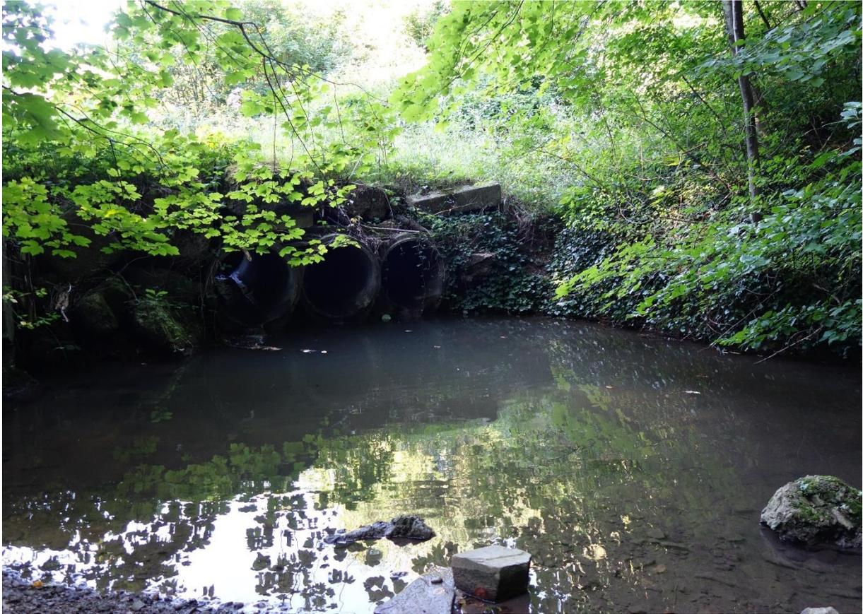
Abbildung 96: Auskolkung nach einem Rohrdurchlass bachaufwärts der Dornbachbrücke (Foto: BPWW/J. Scheiblhofer)
