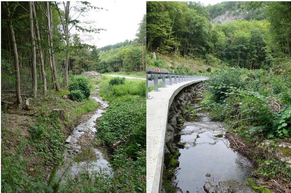
**Abbildungen 104 und 105: Uferverbauungen am Unterlauf des Rosentalbaches (Fotos: BPWW/J. Scheibelhofer)**
