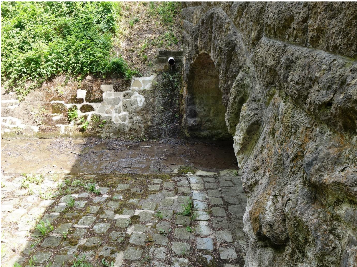
Abbildung 27: Sohlplasterung bei der Kanalbrücke über den Flammersbach (Foto: BPWW/J. Scheibhofer)
