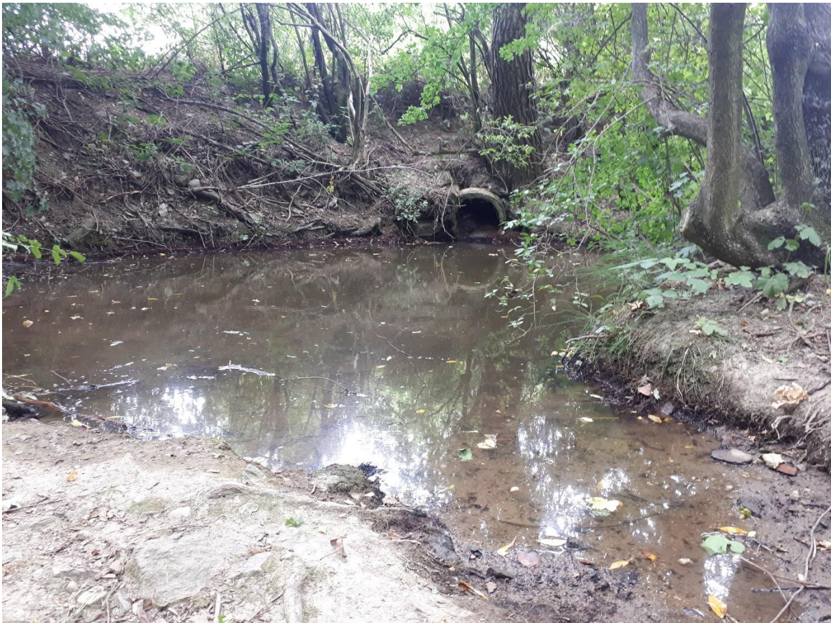
Abbildung 75: Unterrohrung des Plattenbaches beim Recyclinghof (Foto: BPWW/J. Scheiblhofer)
