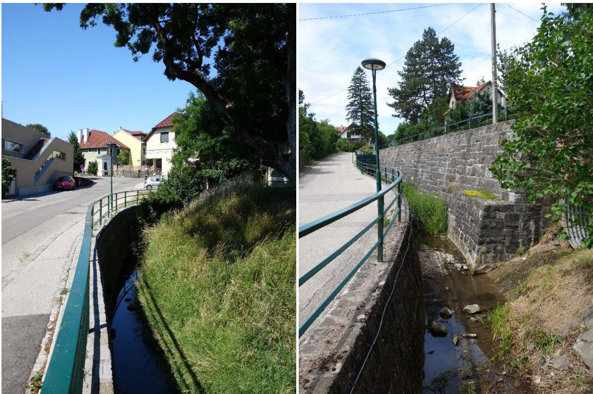
Abbildungen 72 und 73: Der Laaber Bach ist im Ortsgebiet hart verbaut (Fotos: BPWW/J. Scheibhofer)
