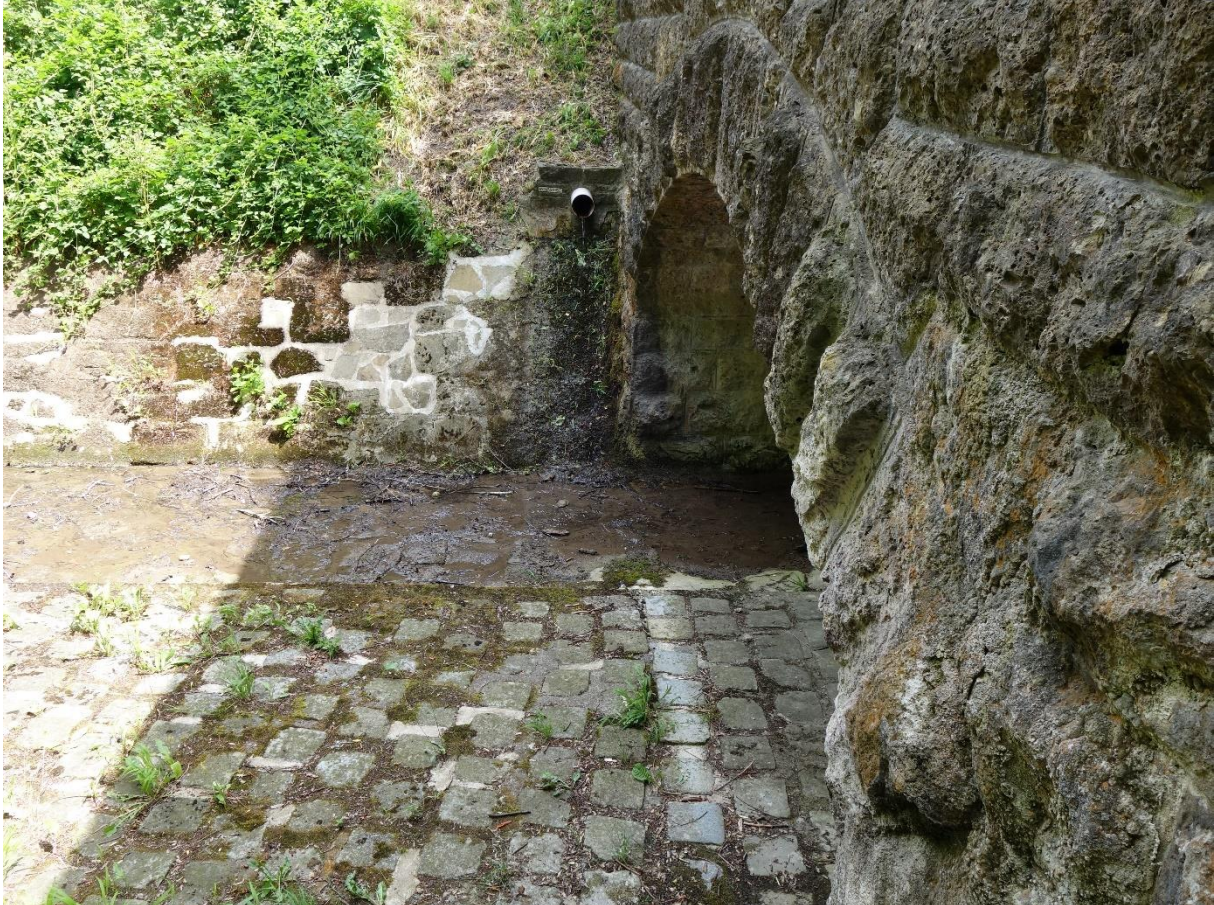
Abbildung 70: Sohlpflasterung bei der Kanalbrücke über den Flammersbach (Foto: BPWW/J. Scheiblhofer)
