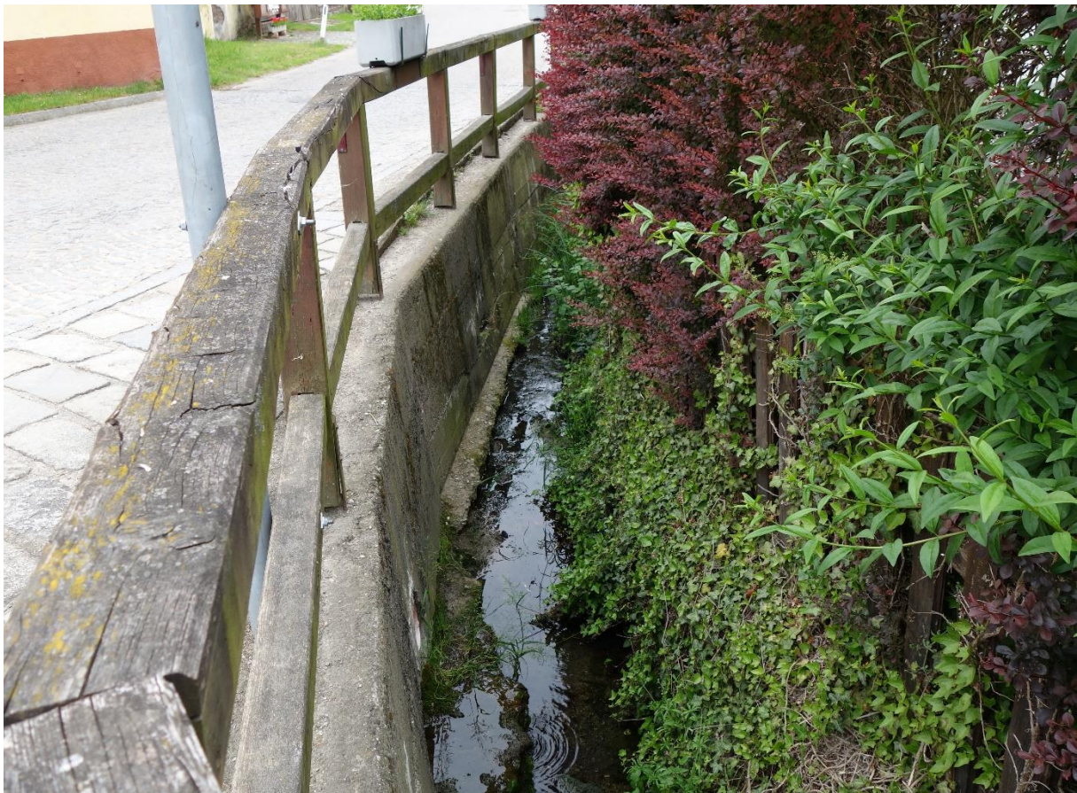
Abbildung 53: Verbauter Markersdorfer Bach im Ortsgebiet (Foto: BPWW/J. Scheiblhofer)
