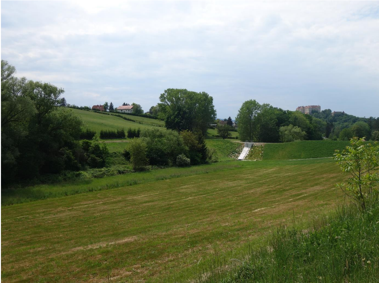
Abbildung 48: Rückhaltebecken am Kirschnerwaldbach (Foto: BPWW/J. Scheiblhofer)
