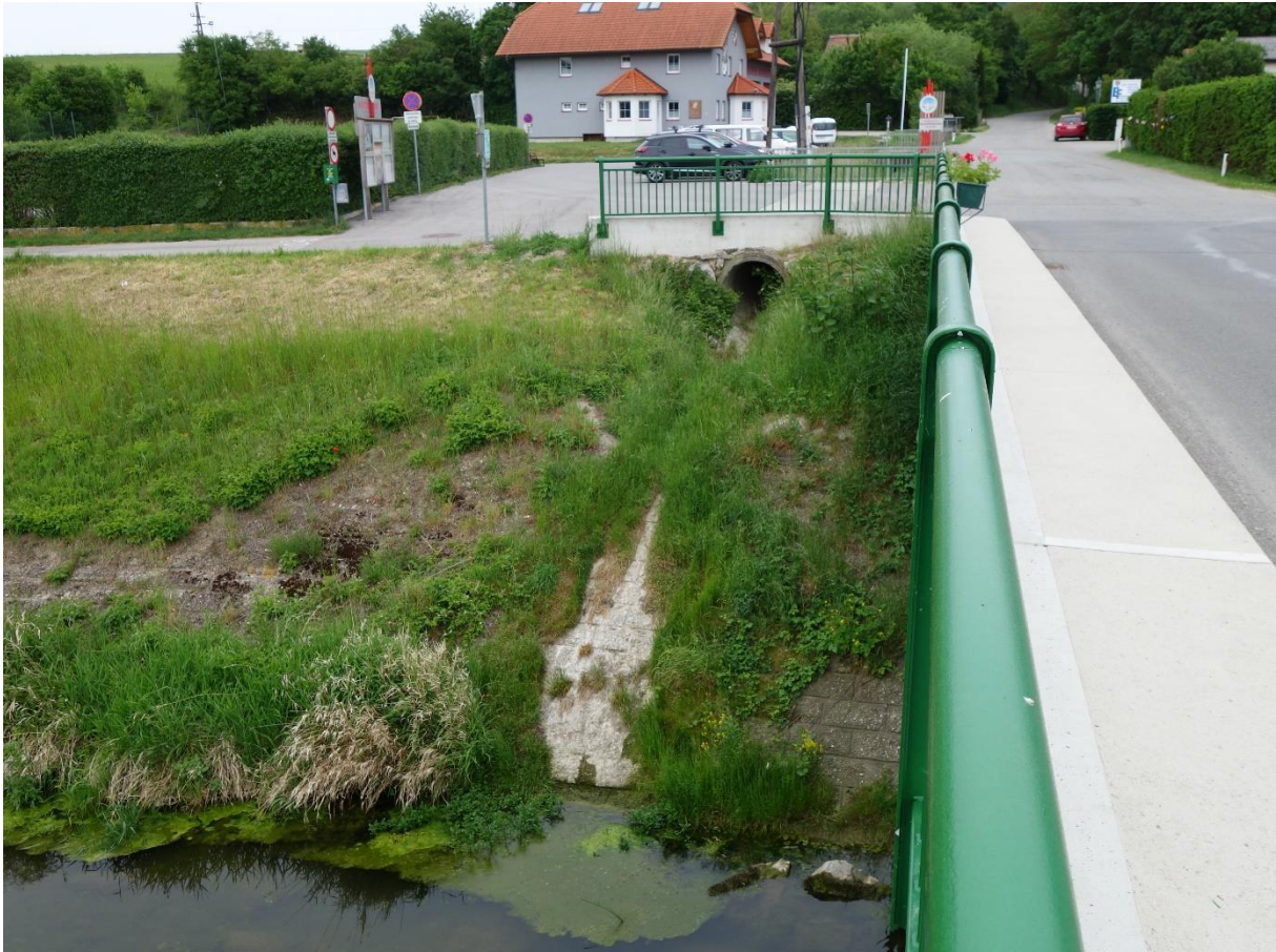
Abbildung 54: Die Einmündung des Markersdorfer Baches in die Große Tulln erfolgt über eine vier Meter hohe befestigte Böschung (Foto: BPWW/J. Scheibelhofer)
