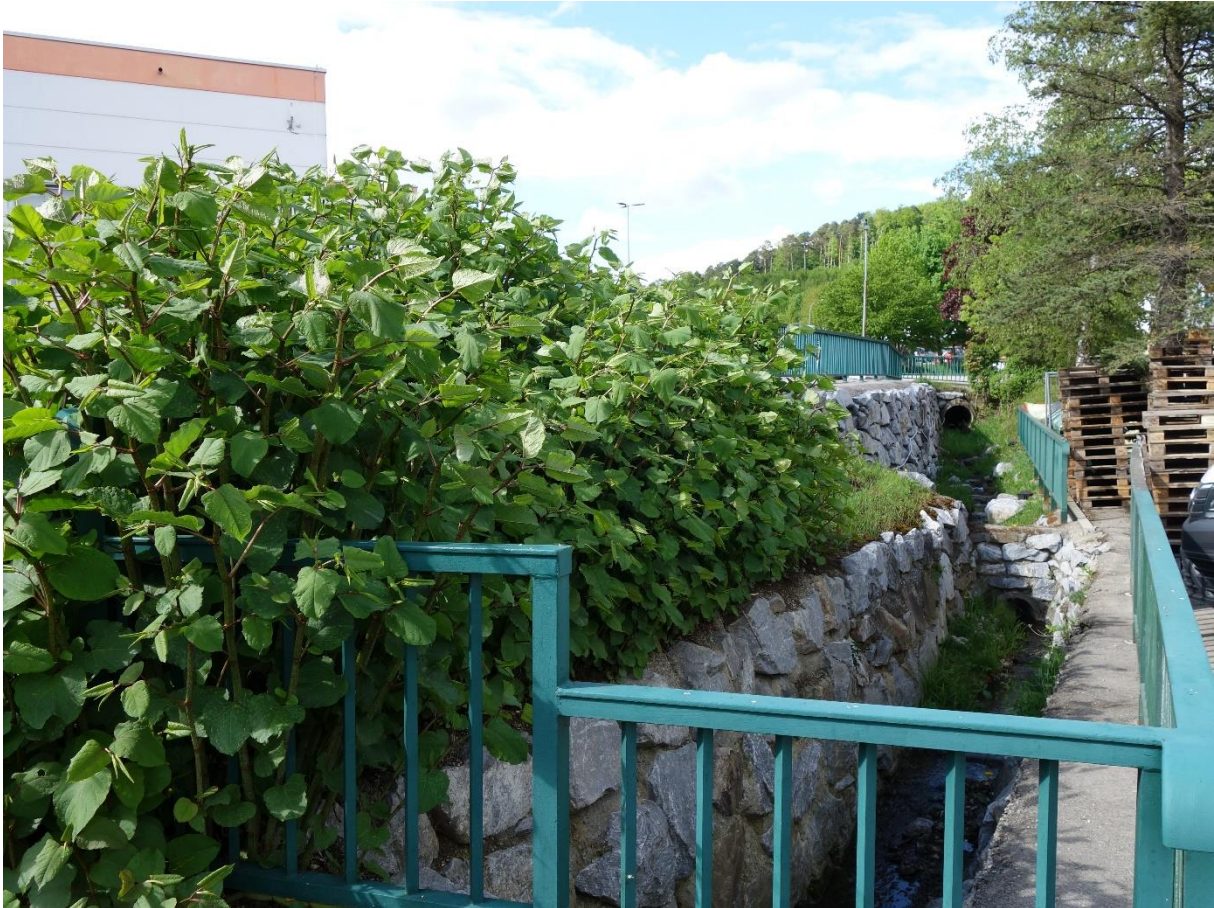
Abbildung 81: Uferverbauung und Staudenknöterich-Dominanzbestände am Rehgraben vor der Einmündung in den Gablitzbach (Foto: BPWW/J. Scheiblhofer)
