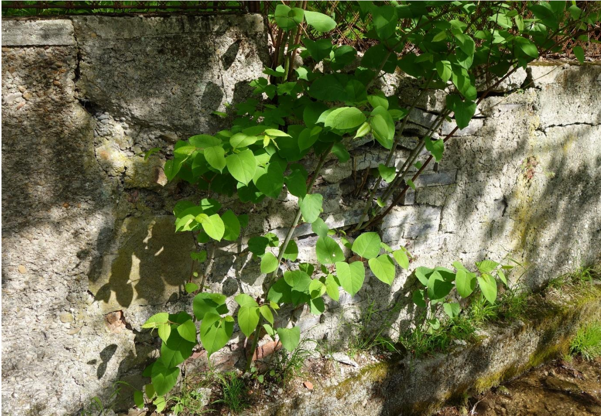
Abbildung 95: Der Staudenknöterich ist in der Lage, mit seinen Rhizomen Mauerwerk und Beton zu sprengen, wie hier am Karlgraben (Foto: BPWW/J. Scheiblhofer)
