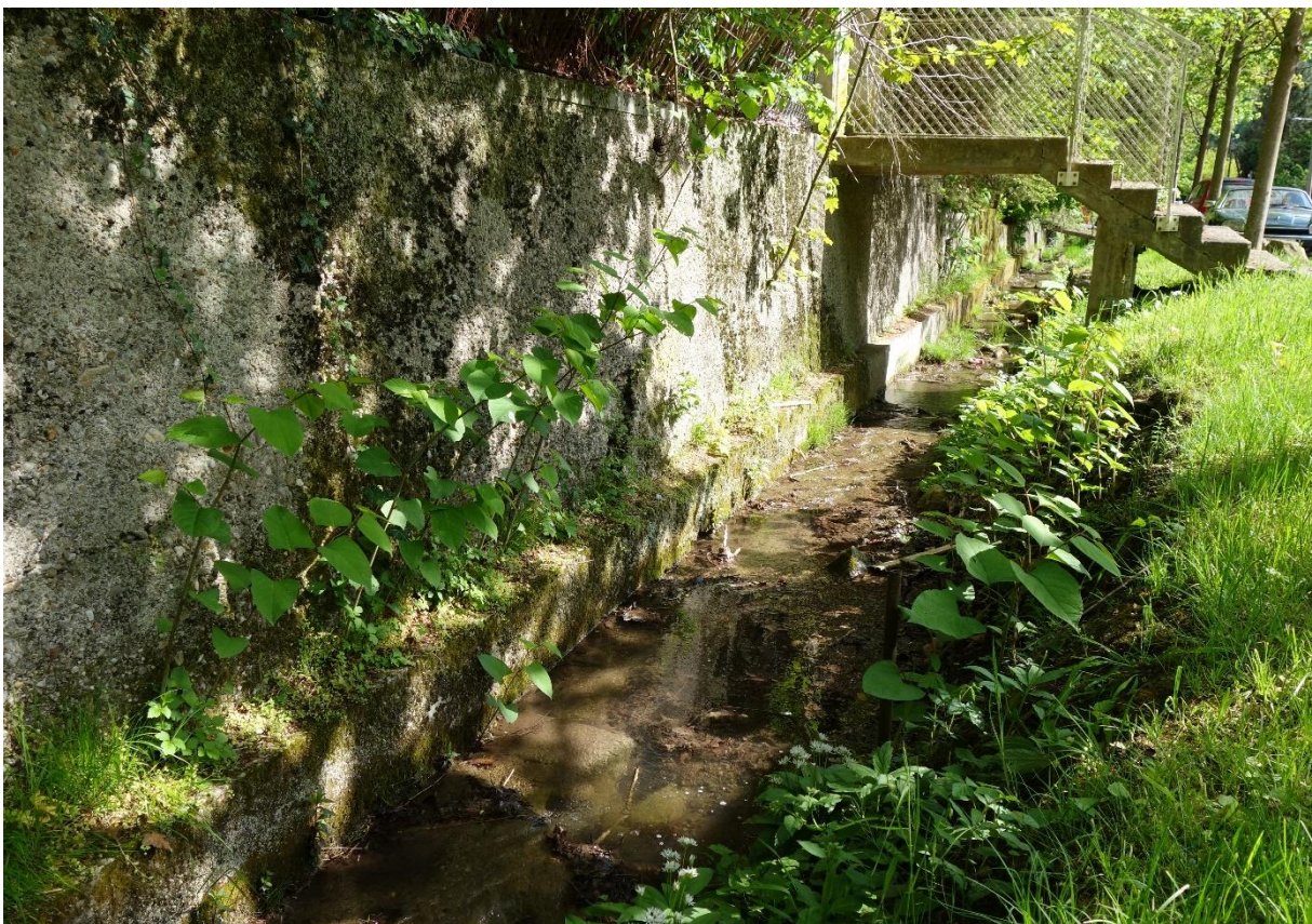
Abbildung 75: Harte Uferverbauung und Staudenknöterich an der Karlgasse (Foto: BPWW/J. Scheiblhofer)
