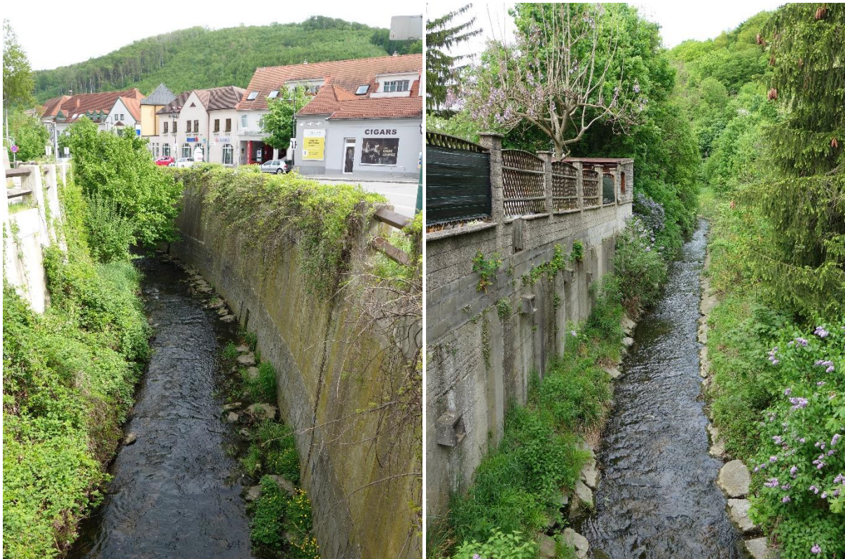
Abbildungen 65 und 66: Der Gablitzbach ist im Ortsgebiet von Purkersdorf hart verbaut (Fotos: BPWW/J. Scheiblhofer)
