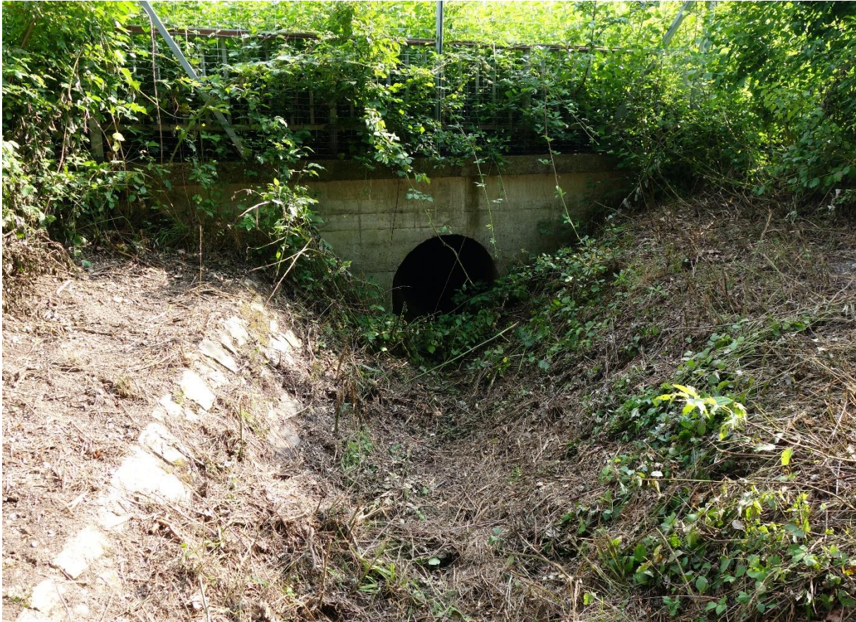
Abbildung 60: Verrohrung unter der Autobahn eines Deutschwaldbach-Zubringers (Foto: BPWW/J. Scheiblhofer)
