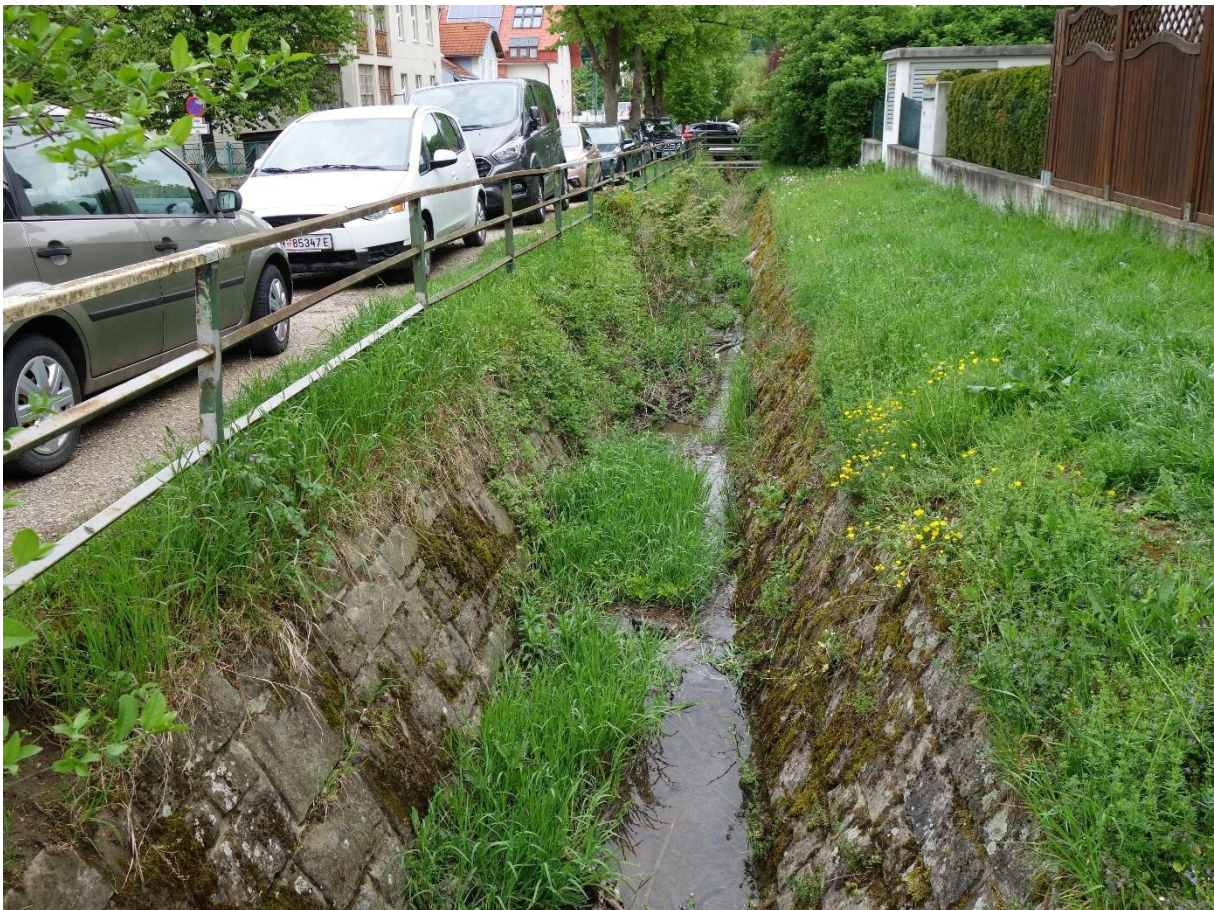
Abbildung 68: Harte Uferverbauung am Georgenbach im Siedlungsgebiet (Foto: BPWW/J. Scheibhofer)
