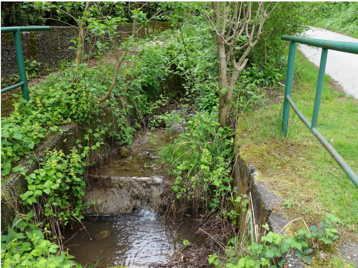
Abbildung 83: Grundschwelle am Schintergraben (Foto: BPWW/J. Scheibhofer)
