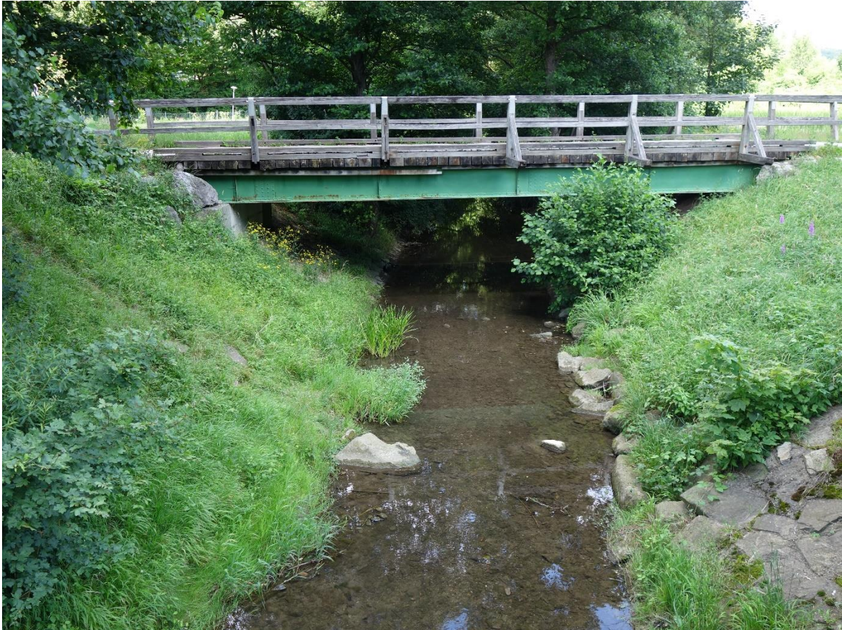
Abbildung 91: Wolfsgrabenbach im Bereich des Autobahn-Talüberganges (Foto: BPWW/J. Scheibelhofer)
