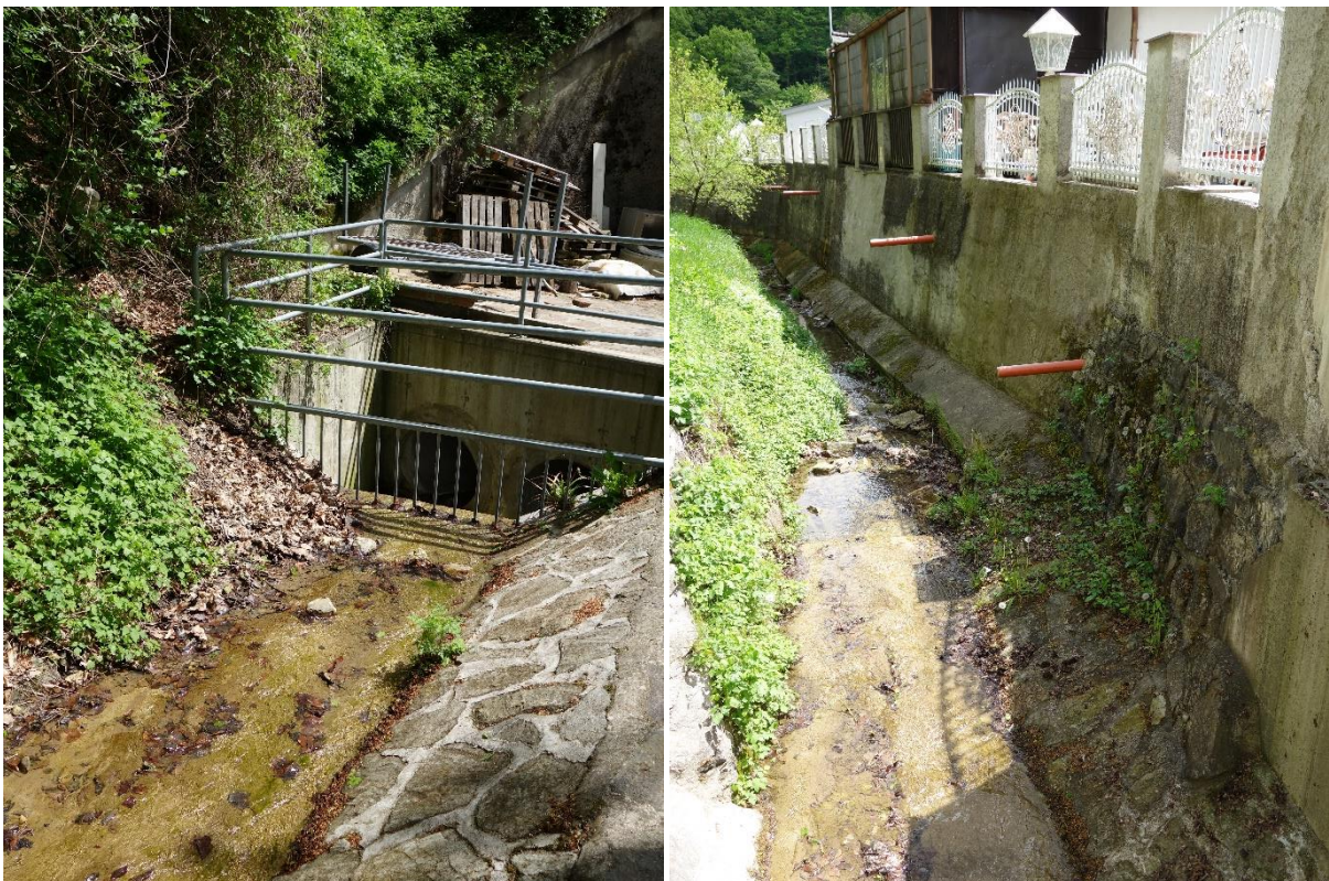
Abbildungen 76 und 77: Der Kleine Steinbach ist ab dem Eintritt ins Siedlungsgebiet aus Hochwasserschutzgründen hart verbaut (Fotos: BPWW/J. Scheibelhofer)
