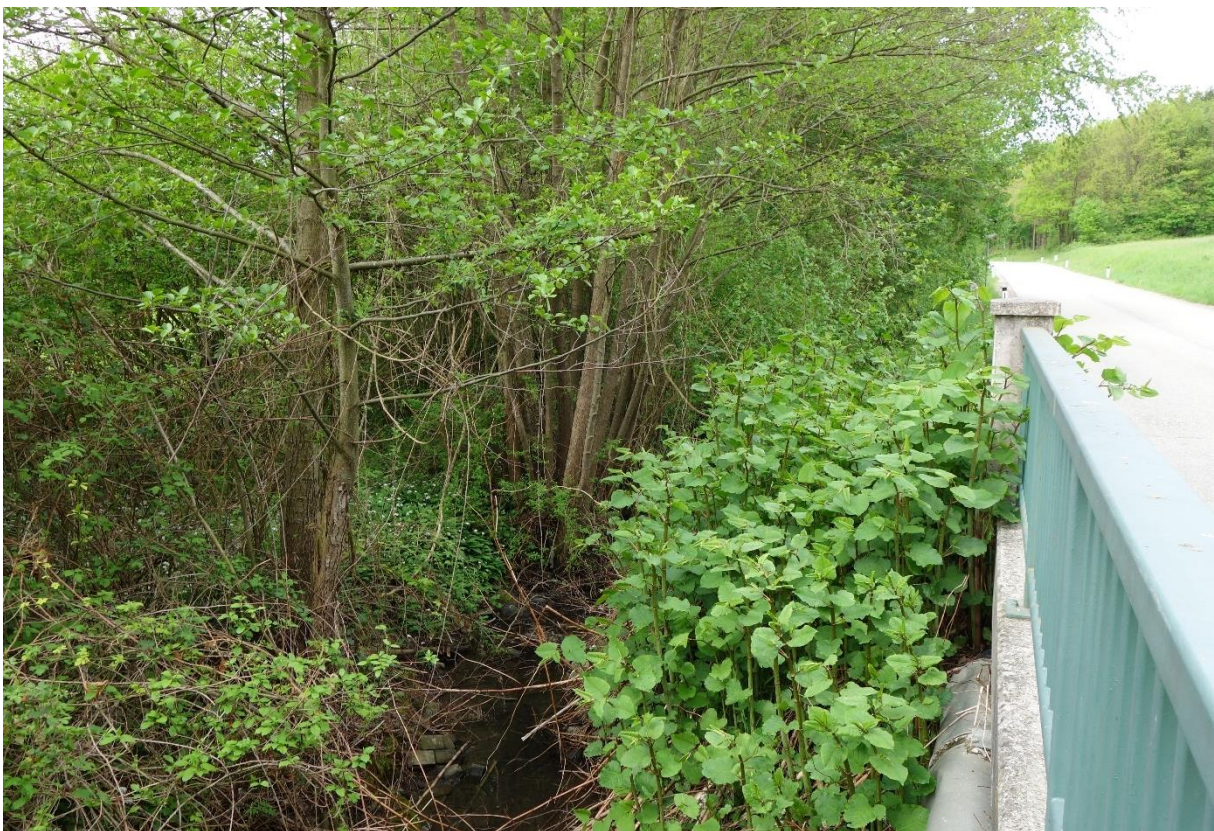
Abbildung 73: Staudenknöterich-Bestand beidseits der Brücke über der Heimbautalstraße (Foto: BPWW/J. Scheibelhofer)
