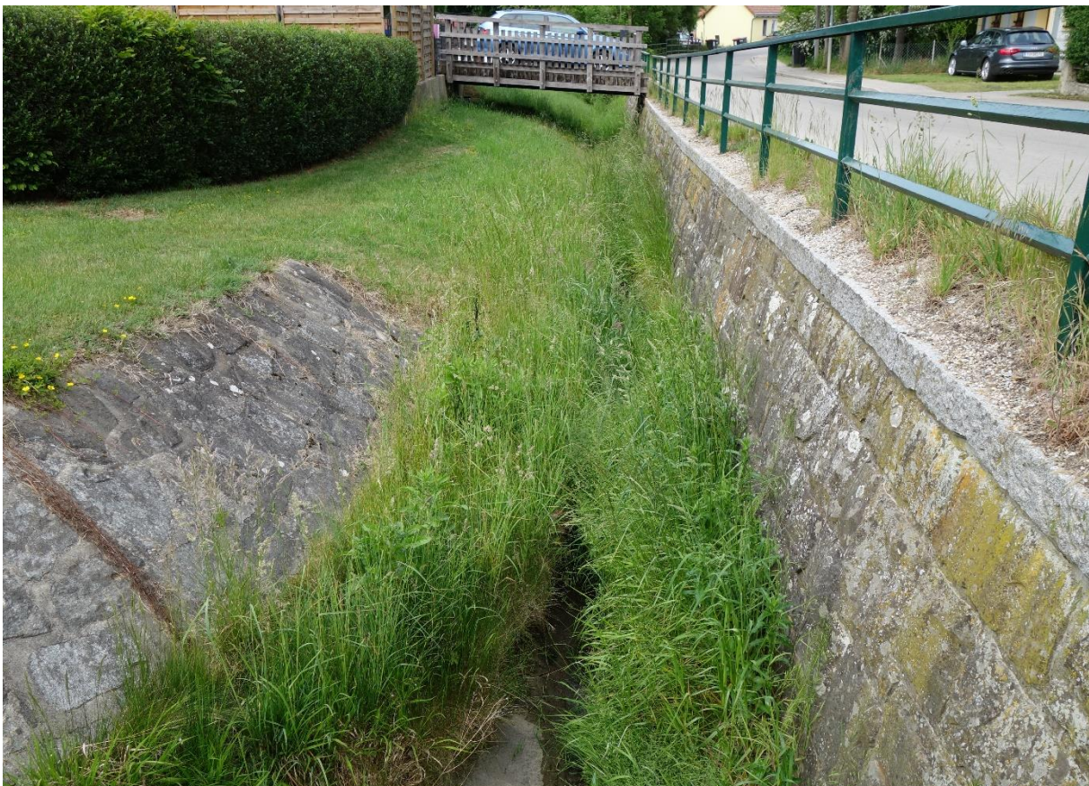
Abbildung 86: Verbauter Bach von Rappoltenkirchen im Ortsgebiet (Foto: BPWW/J. Scheibelhofer)
