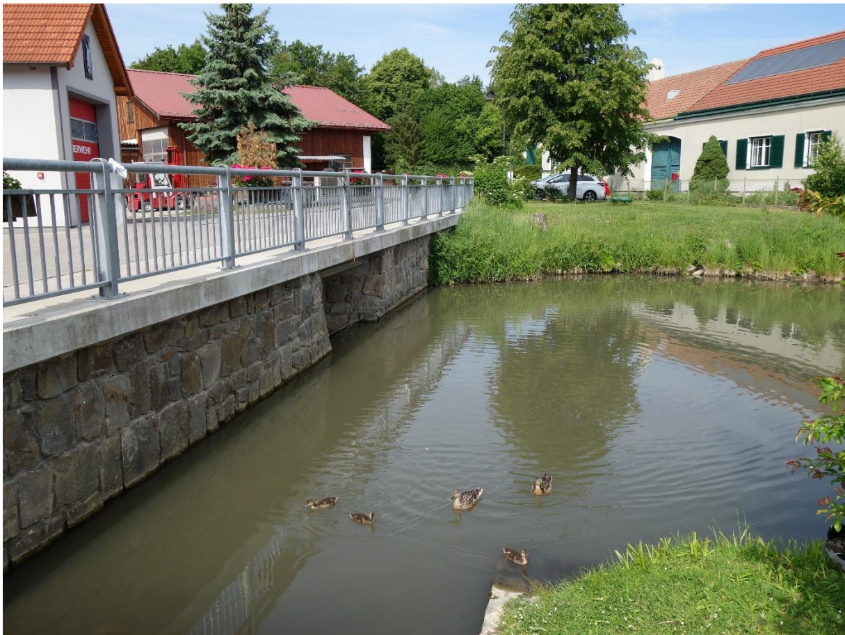
Abbildung 100: Stark verbauter Riederbach im Ortsgebiet von Ried (Foto: BPWW/J. Scheibelhofer)
