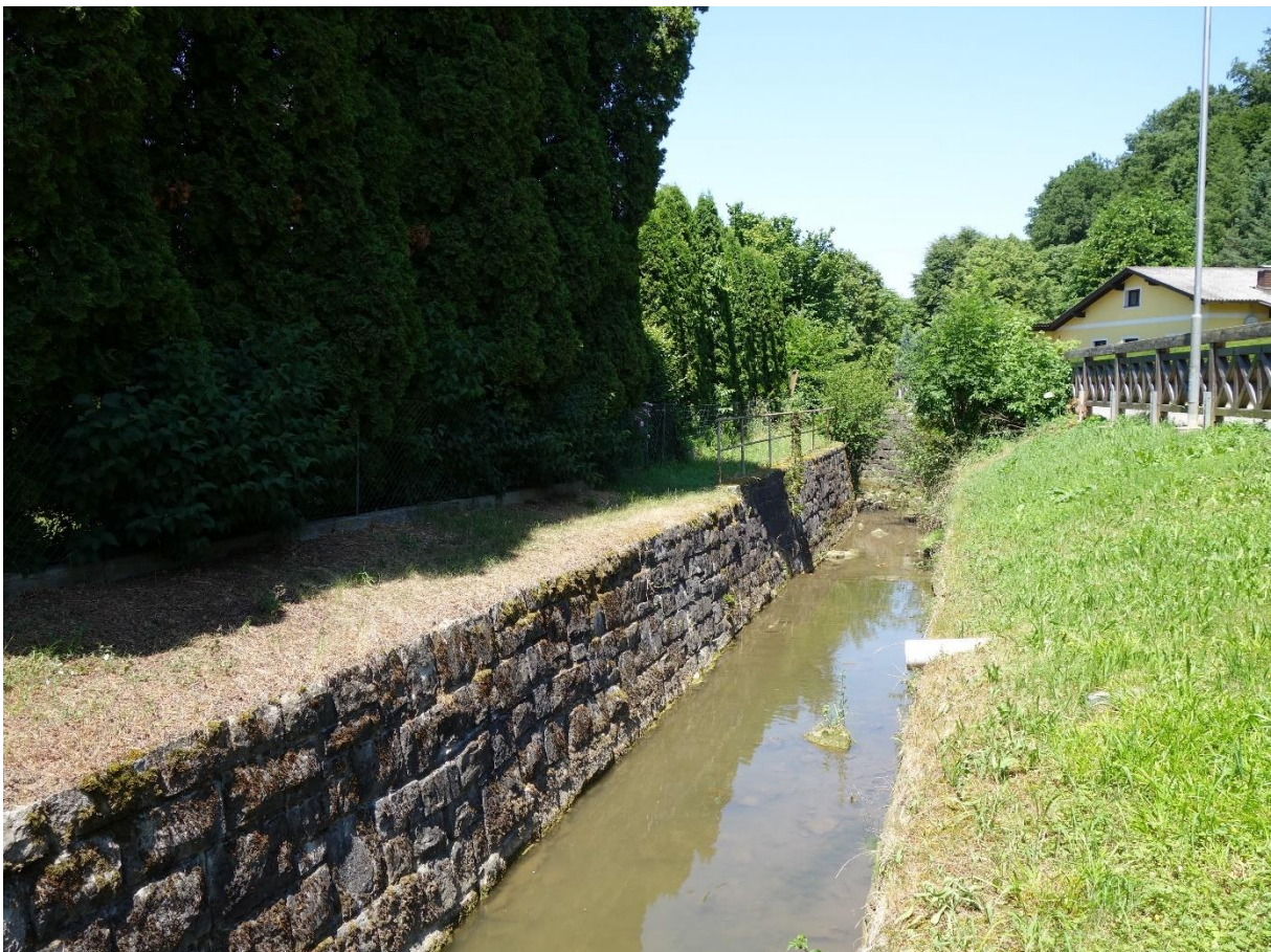
Abbildung 24: Der Wolfsgrabenbach ist im Ortsgebiet aus Hochwasserschutzgründen hart verbaut, hier etwa ein Abschnitt bei der Pfarrkirche (Foto: BPWW/J. Scheiblhofer)
