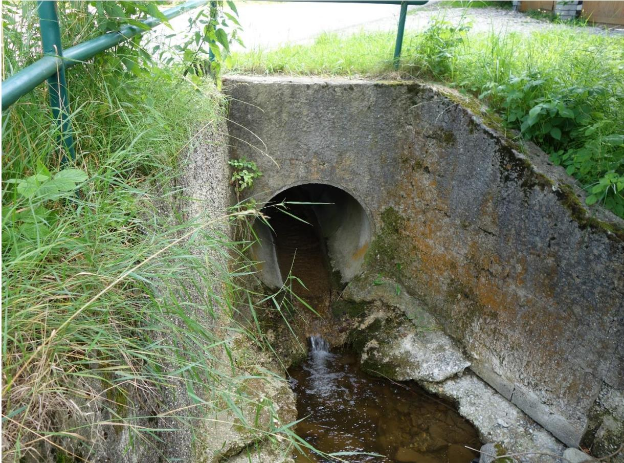
Abbildung 83: Absturz nach einer Verrohrung bei Fellinggraben 3 (Foto: BPWW/J. Scheiblhofer)
