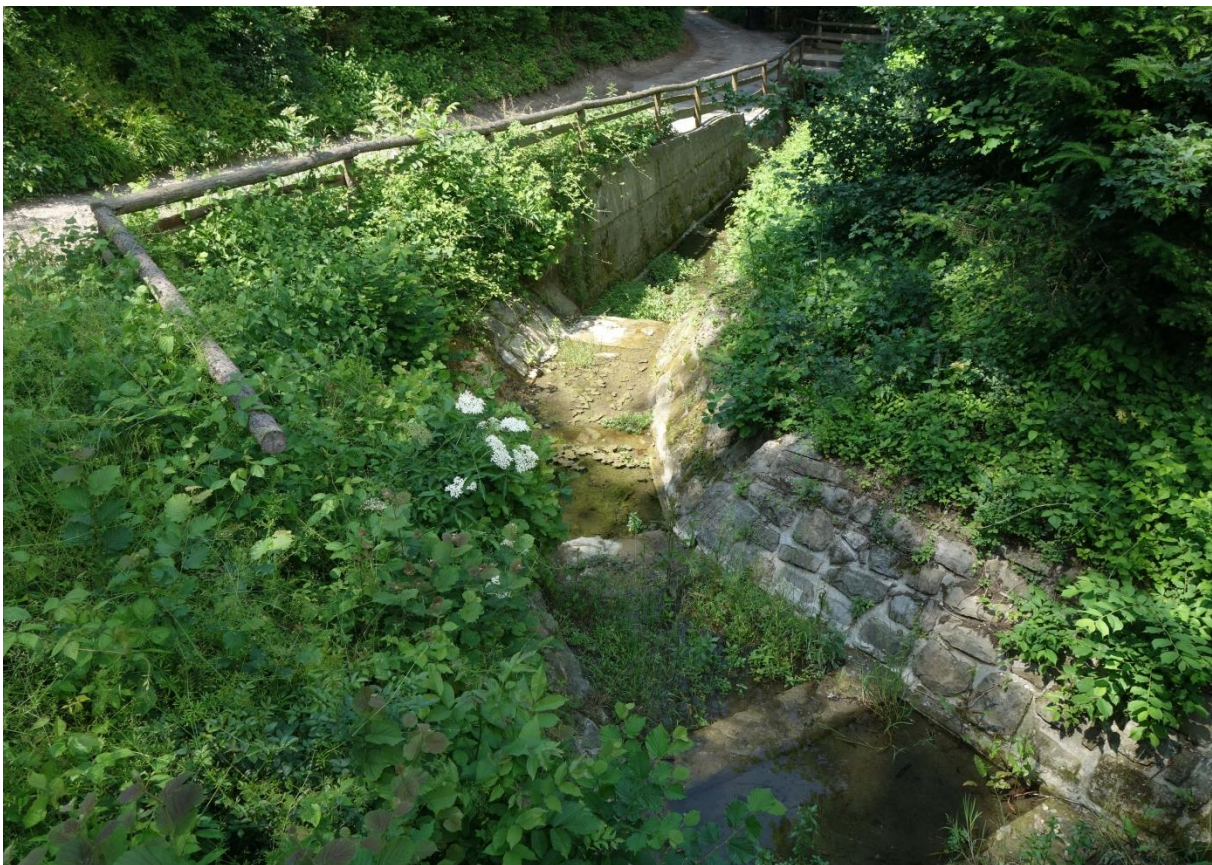
Abbildung 19: Oberer Wolfpassinger Ortsgraben mit Ufer- und Sohlbefestigung sowie Abstürzen (Foto: J. Scheiblhofer)
