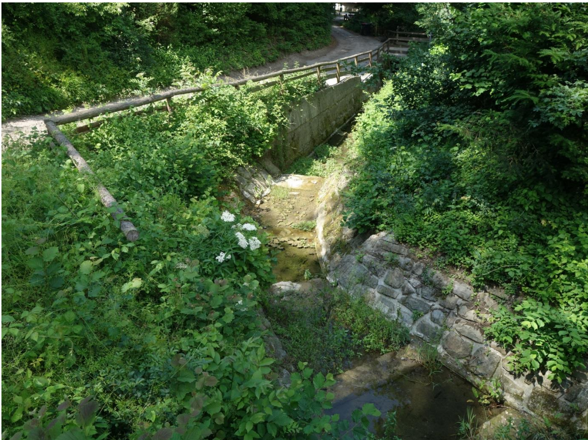
Abbildung 43: Oberer Wolfpassinger Ortsgraben mit durchgehender Uferbefestigung und zahlreichen Sohlabstürzen (Foto: J. Scheiblhofer)
