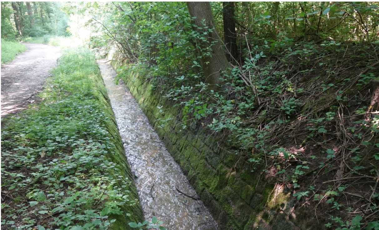
Abbildung 40: „Schussstrecke“ des Oberen Wolfpassinger Ortsgrabens mit befestigten Ufern und Sohle (Foto: J. Scheibhofer)
