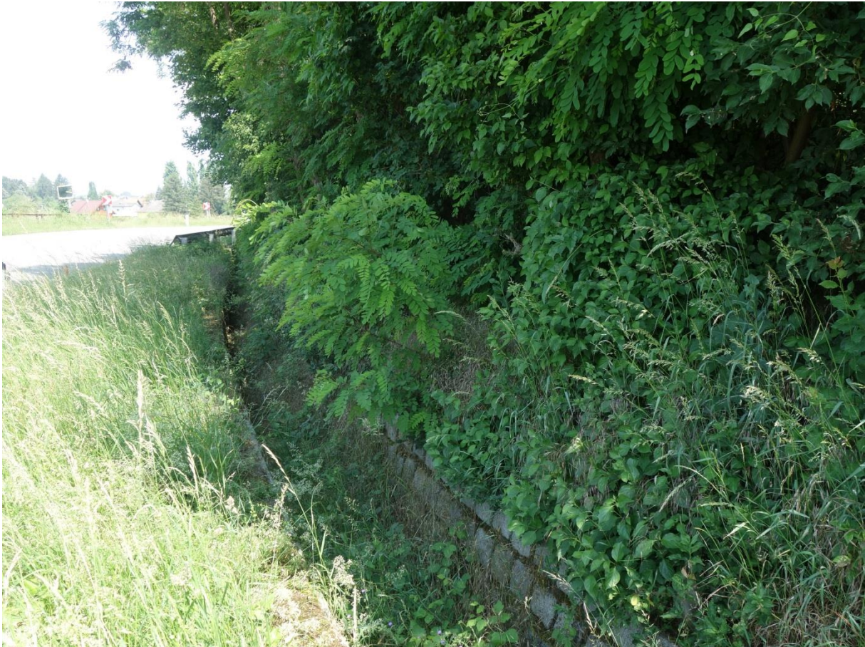
Abbildung 45: Verbauter Abschnitt des Schilleringrabens entlang der Landesstraße mit bestandsbildenden Robinien im Ufergehölz (Foto: J. Scheibelhofer)
