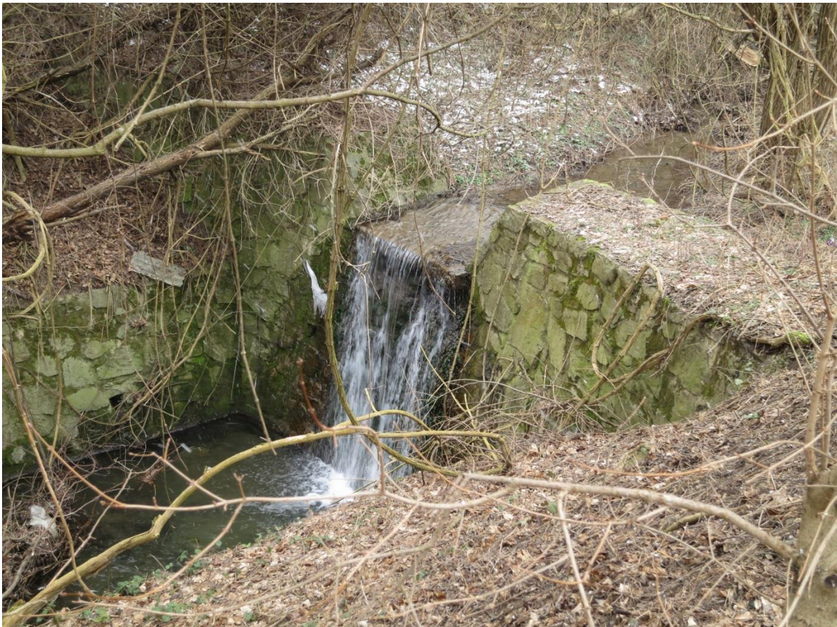
Abbildung 45: Schreiberbach an der Wildgrubgasse mit Uferverbauung und Absturz (Foto: Wikimedia Commons/C. Löser, CC BY 3.0 de)
