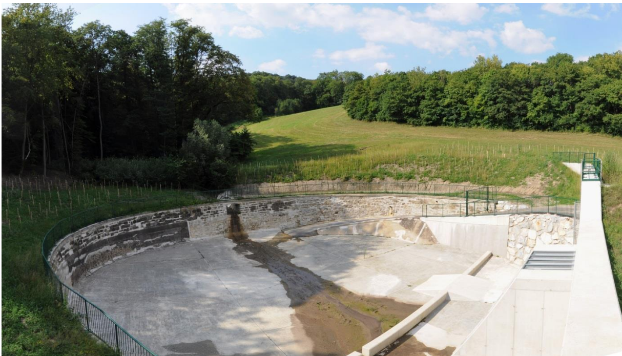
Abbildung 43: Nesselbachbecken nach den Umbauarbeiten 2018 (Foto: Wikimedia Commons/Linie29, CC BY-SA 4.0)
