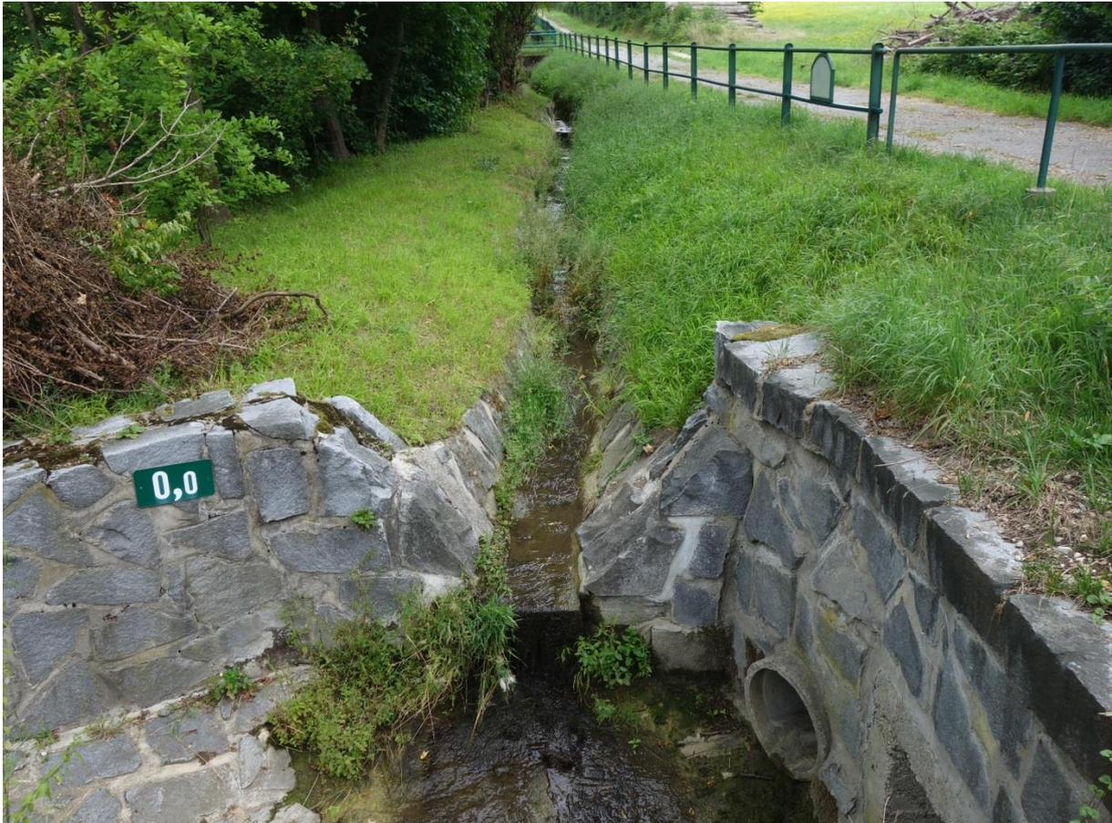
**Abbildung 40: Komplett verbauter und/oder verrohrter Quellengraben (Foto: J. Scheiblhofer)**
