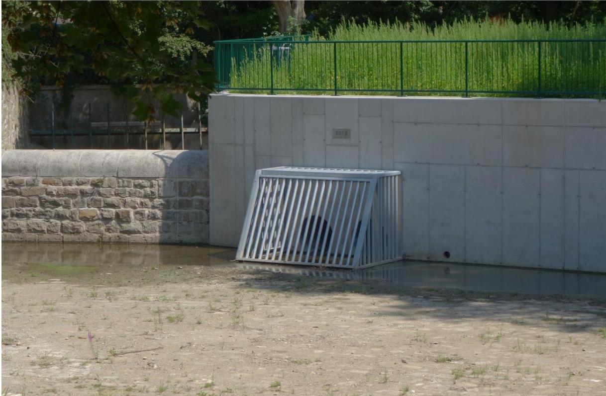
Abbildung 37: Einlaufbauwerk des Alsbaches im Bereich der Marswiese (Foto: J. Scheiblhofer)
