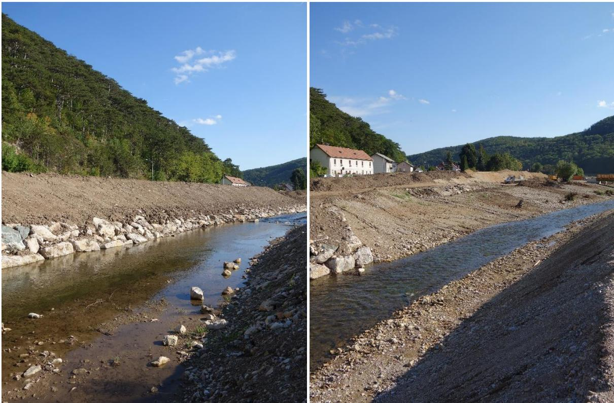
Abbildungen 60 und 61: Bei Fahrafeld wird derzeit ein Rückhaltebecken gebaut (Fotos: BPWW/J. Scheibelhofer)
