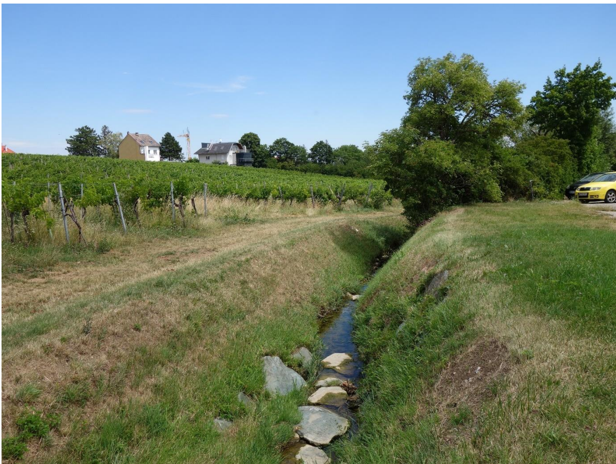
Abbildung 15: Begradigter und veränderter Hochleitenbach an der Brunnerbergstraße (Foto: BPWW/J. Scheibhofer)
