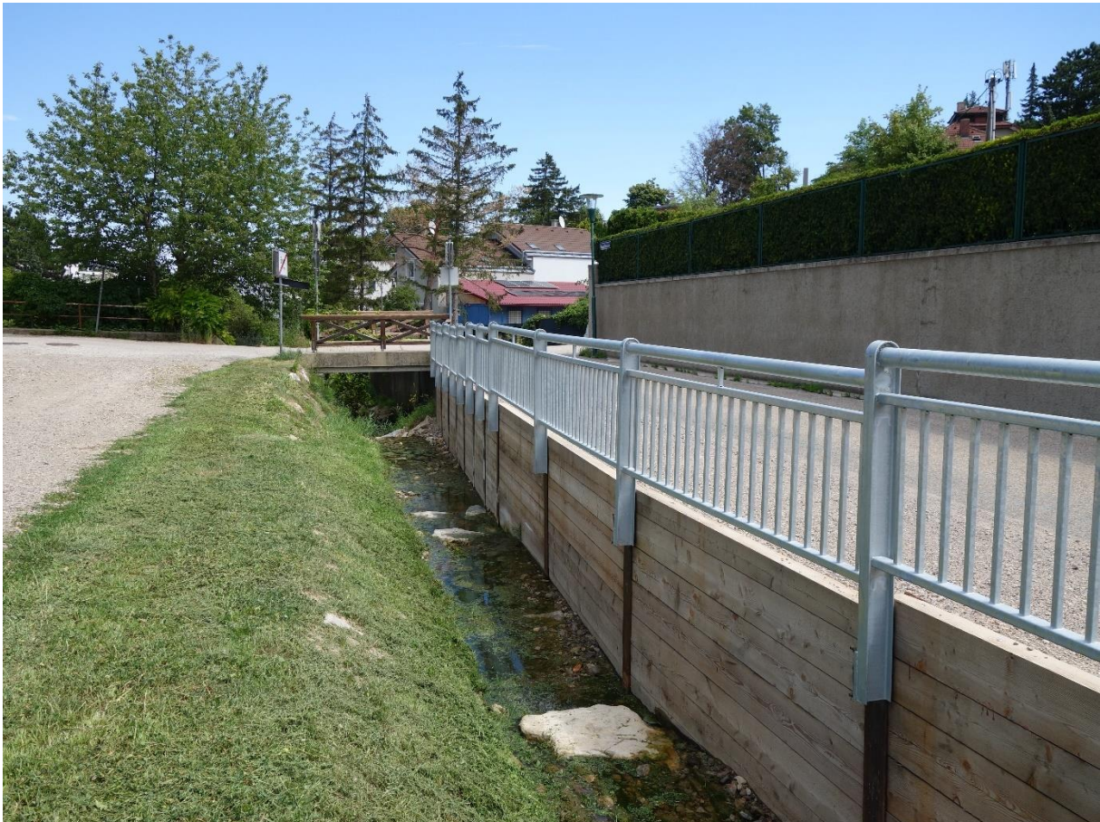
Abbildung 16: Uferbefestigung und Begradigung des Hochleitenbaches im Siedlungsgebiet (Foto: BPWW/J. Scheibhofer)
