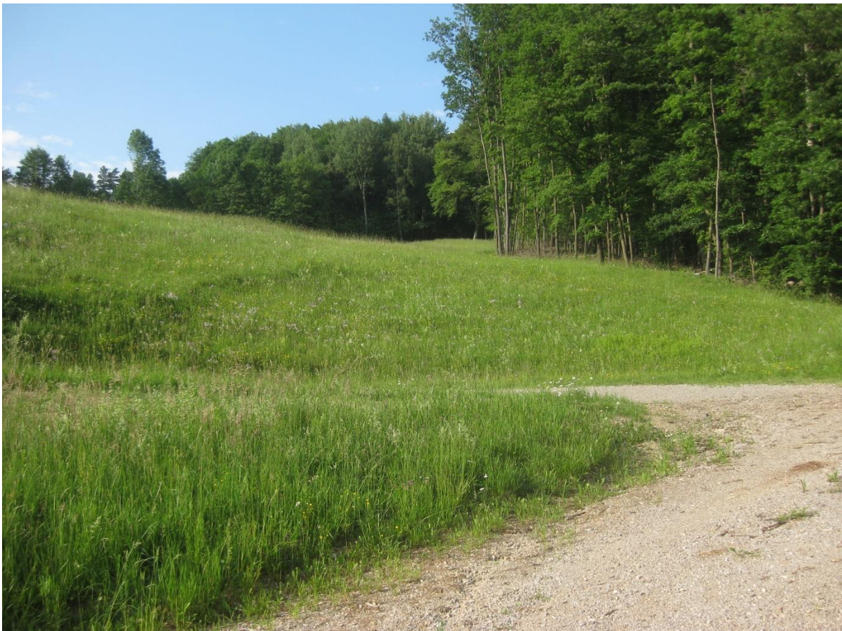
Abbildung 43: Böschungen im Bereich einer Güterweg-Zufahrt südöstlich von Hochberg (Foto: BPWW/P. Biskup)
