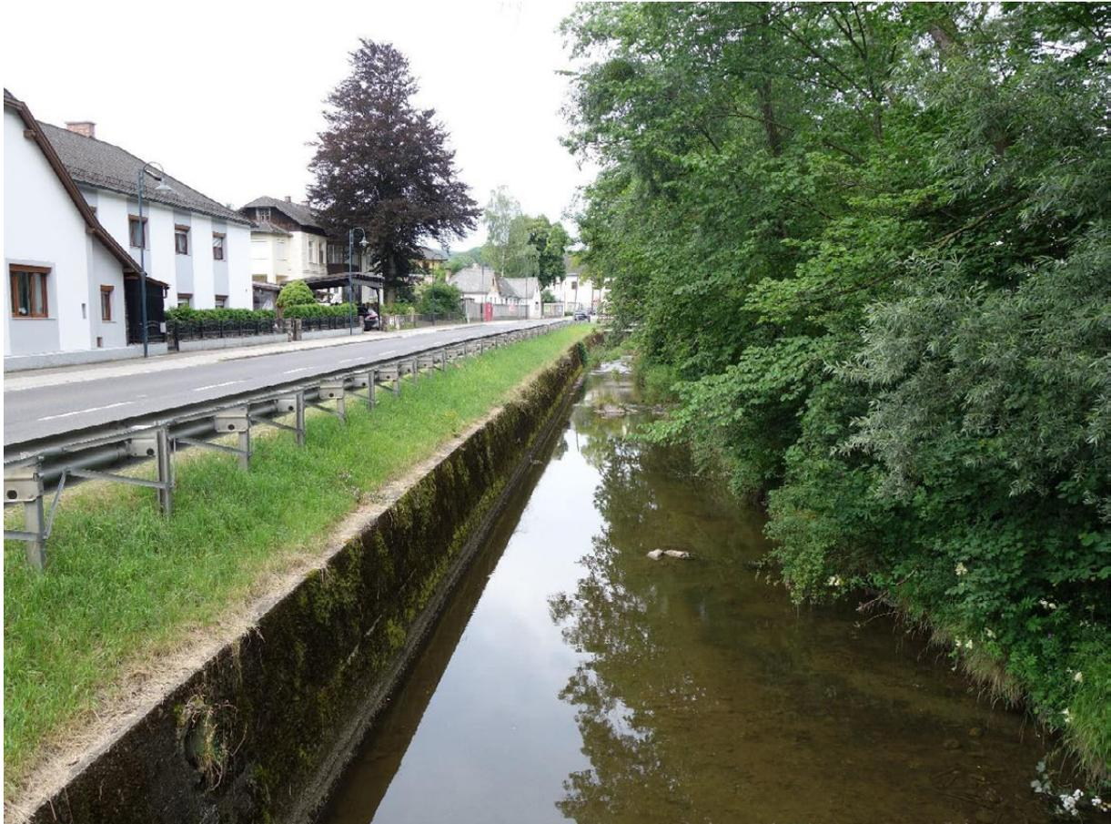
**Abbildung 141: Hart verbauter Abschnitt der Triesting in Thenneberg (Foto: BPWW/J. Scheibhofer)**
