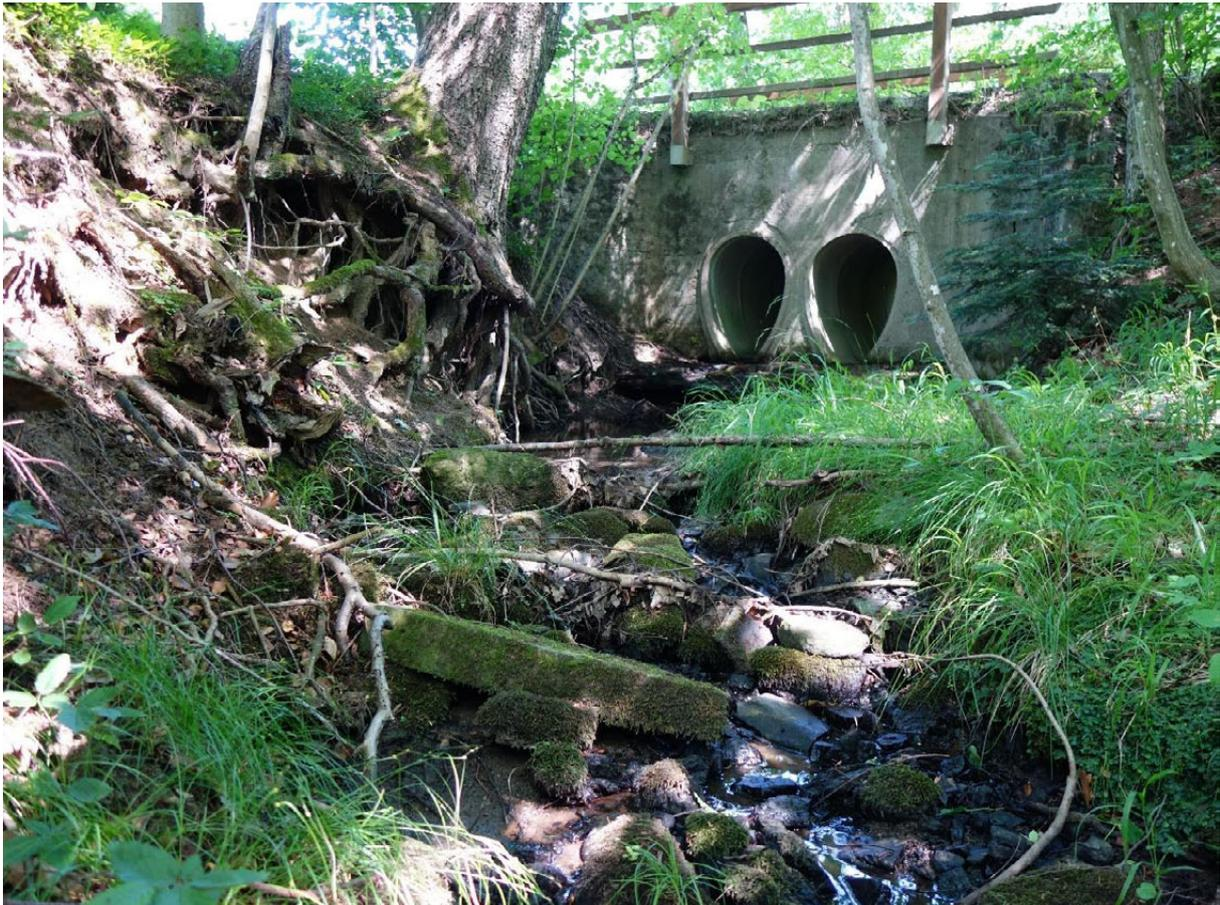
Abbildung 139: Sieglhofgraben mit Verrohrung unter einer Forststraße (Foto: BPWW/J. Scheibhofer)
