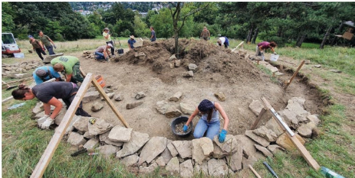
Im September 2020 bauten TeilnehmerInnen des Trockensteinmauerkurses eine runde Steinmauer als Ergänzungsbiotop auf einen wertvollen Trockenrasen im 19. Bezirk.
