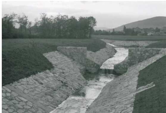
Abb. 5: Einmündung Laaber Bach nach der Verbauung Foto: Museum Breitenfurt
